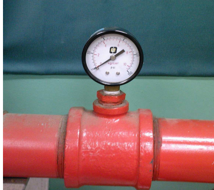
Figura 5. Medidor de Presión Absoluta. Fuente: Autores.
