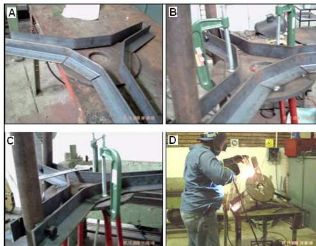
Figura 36. Construcción del módulo de unión inferior
