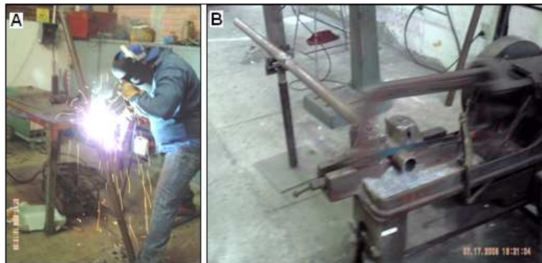
Figura 35. (a) Soldadura aplicada a las patas superiores (b) Corte de la pata superior en la segueta eléctrica
