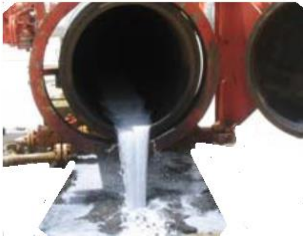
Figura 80 Condensación de líquidos en gasoductos
