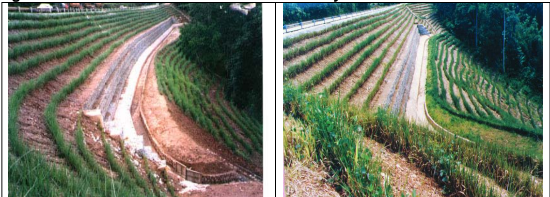
Figura 23. Estabilización taludes de vías - Malaysia.
