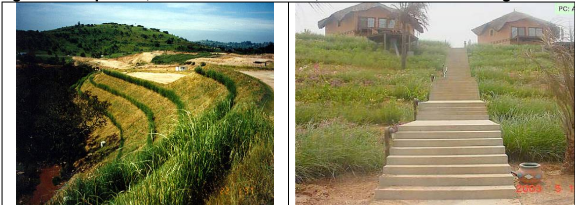
Figura 24. Izquierda, Zona Industrial - USA, Derecha Taludes - Senegal.
