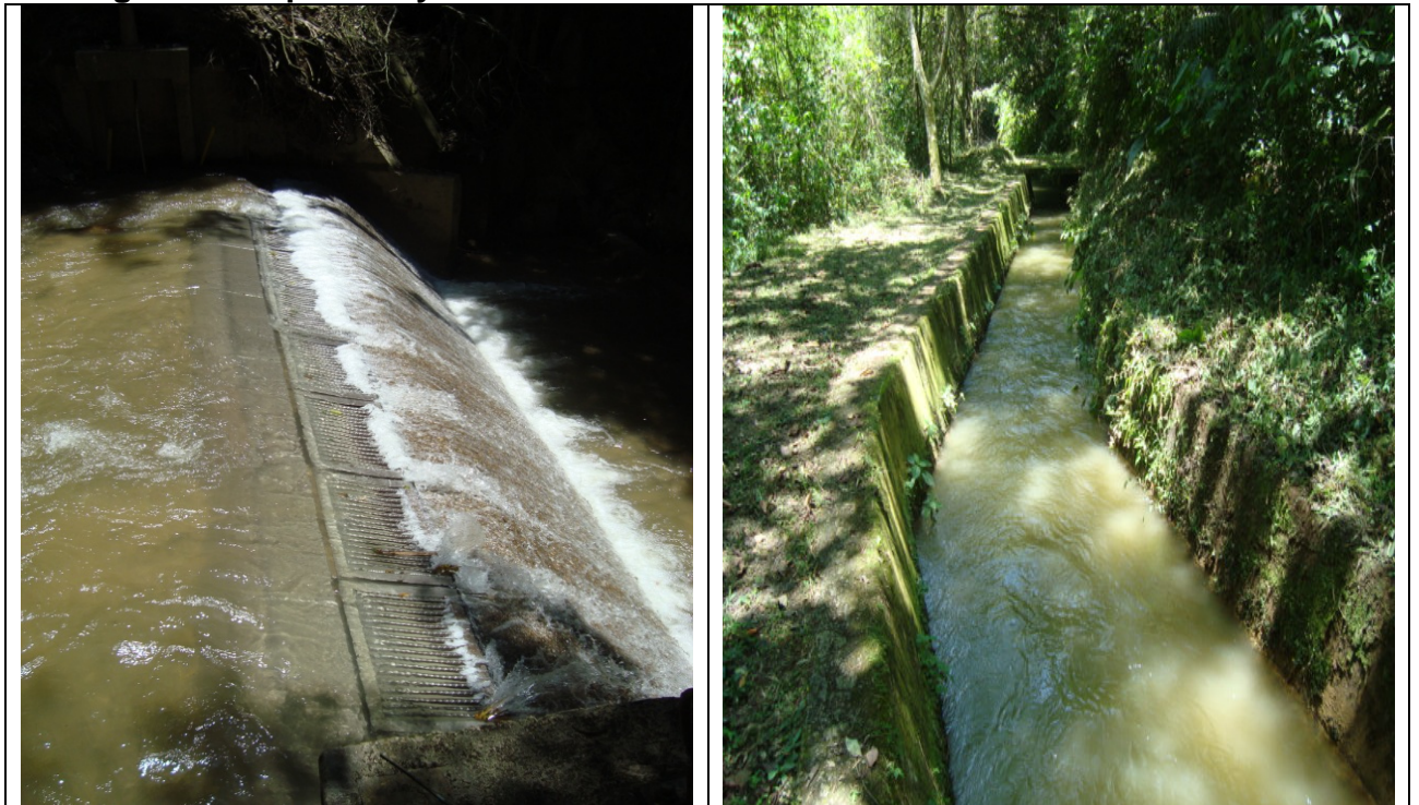
Figura 34 Captación y canal de aducción.
