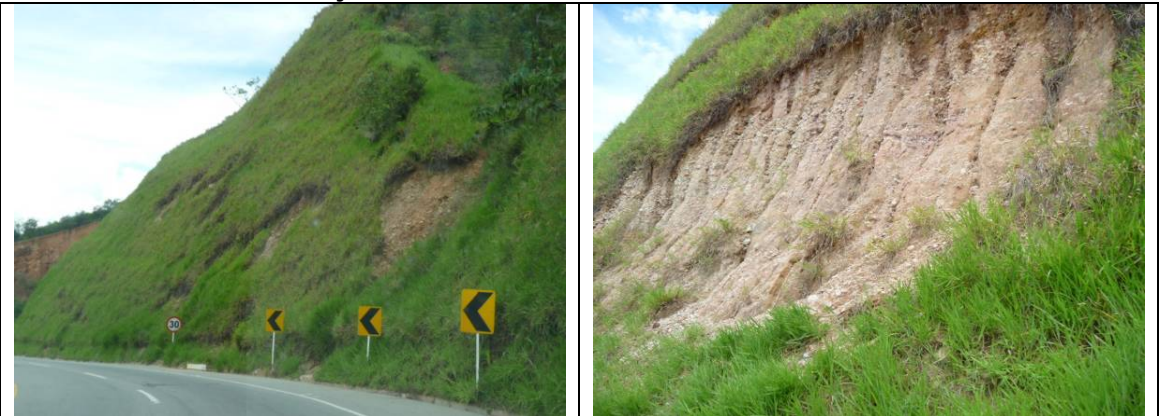
Figura 32 Taludes revegetalizados sin Vetiver y sin canales de manejo de escorrentías, vía Lebrija – Girón - Santander.
