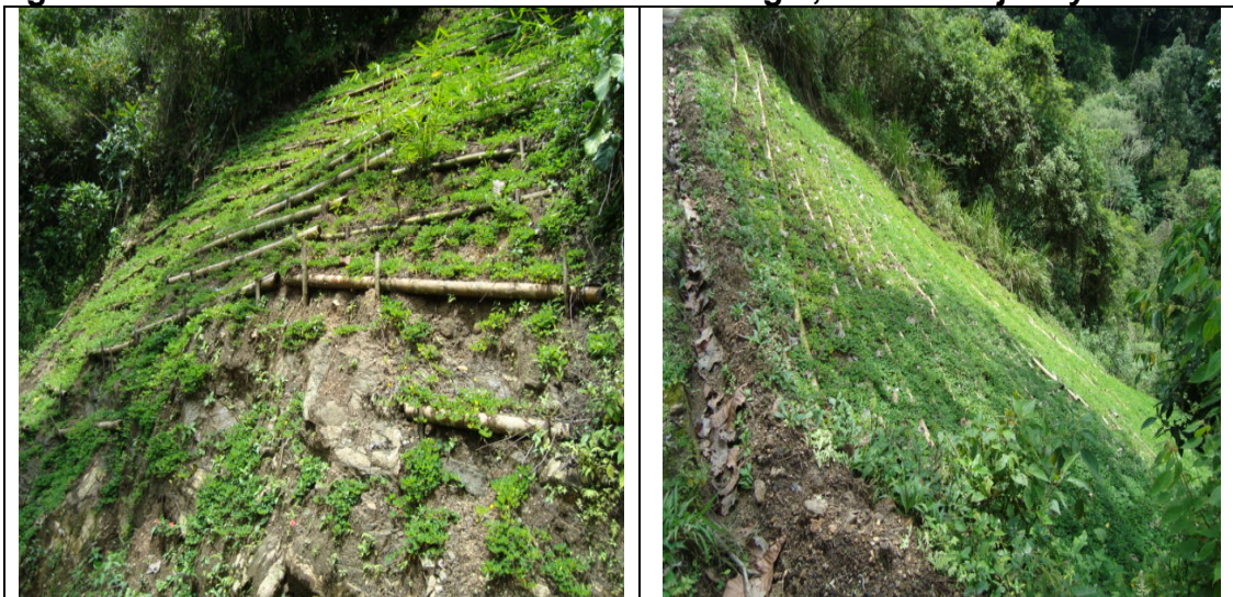
Figura 36 Taludes estabilizados con biotecnología, Maní forrajero y Guadua.
