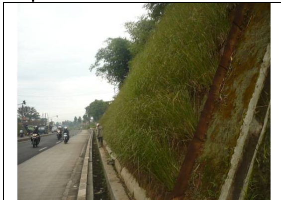
Figura 28 Talud de alta pendiente con Vetiver - Java
