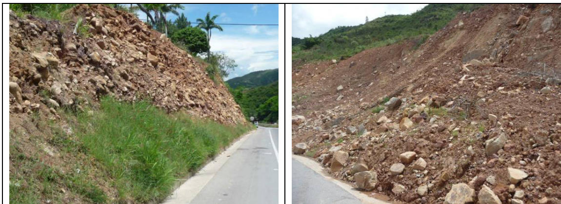
Figura 29 Taludes con elementos de gran tamaño, vía Lebrija – Giron - Santander.
