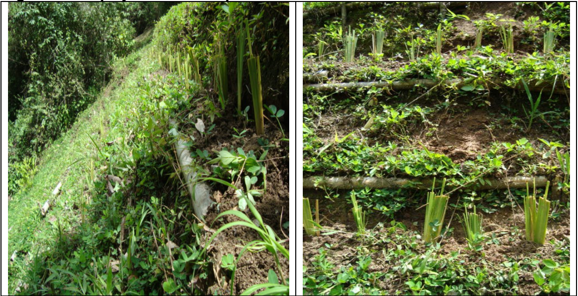
Figura 41 Esquejes de vetiver plantados en curva de nivel.
