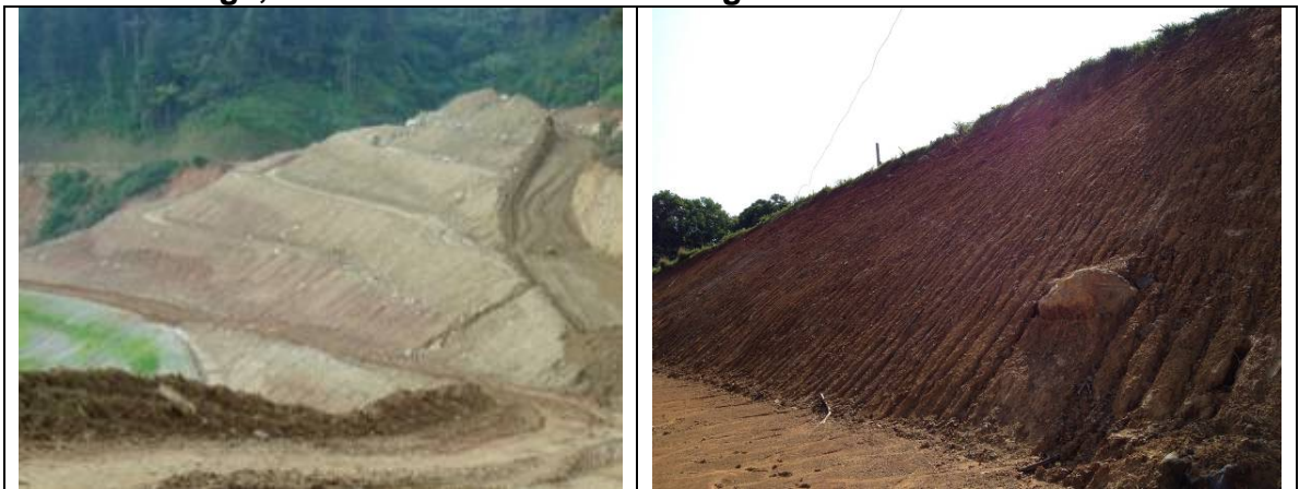
Figura 33 Taludes susceptibles de estabilización con Vetiver, Izq Vía Cúcuta – Bucaramanga, Der. Via sustitutiva Hidrosogamoso.
