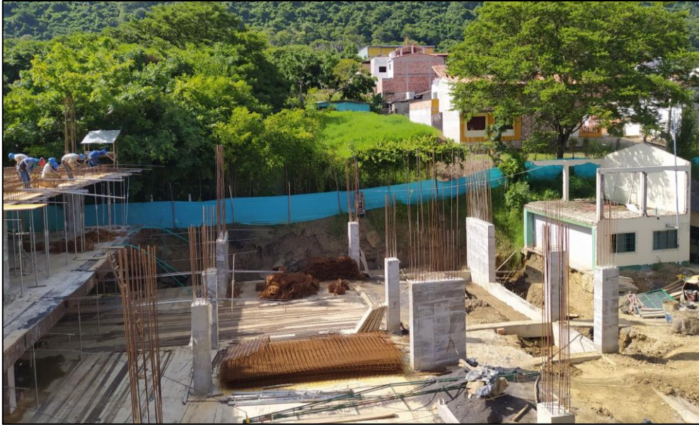
Figura 9. Viviendas aledañas, visita de obra realizada el 23 de junio de 2022.
