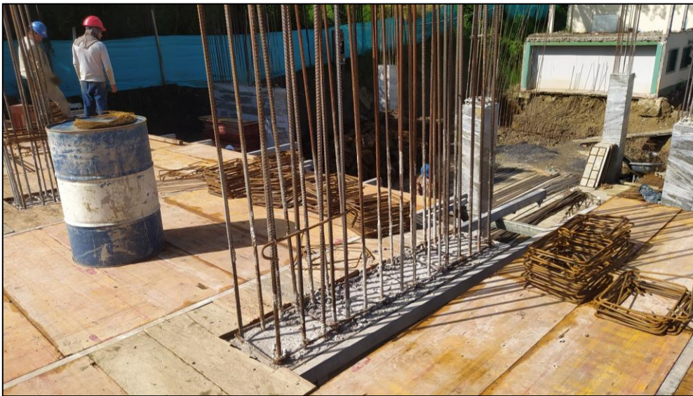
Figura 10. Armado de muro pantalla, visita de obra realizada el 12 de mayo de 2022.
