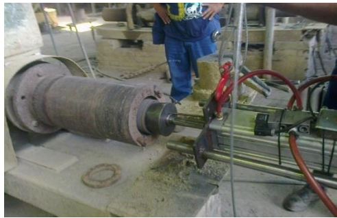
FIGURA 49. DISPOSITIVO DE EXTRACCIÓN EN LA FUNDIDORA
