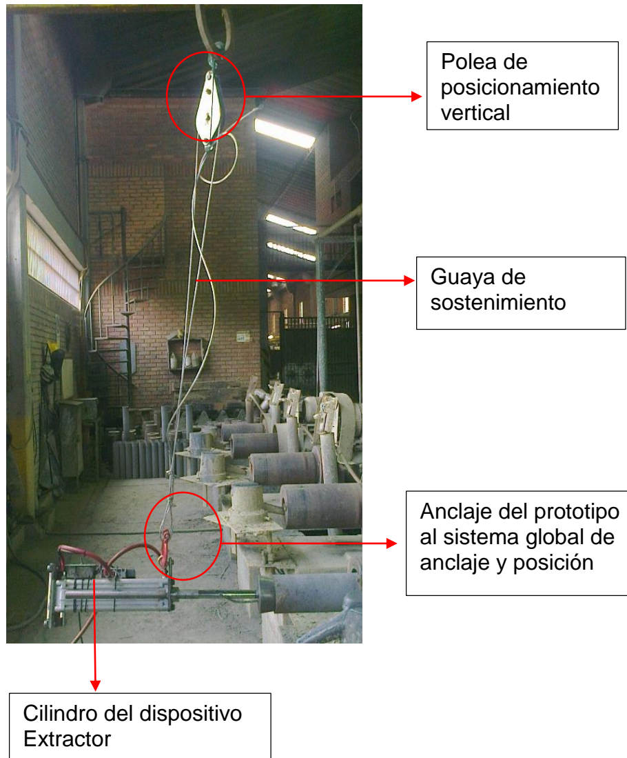
FIGURA 55. POLEA, GUAYA Y ANCLAJE DEL SISTEMA EXTRACTOR
