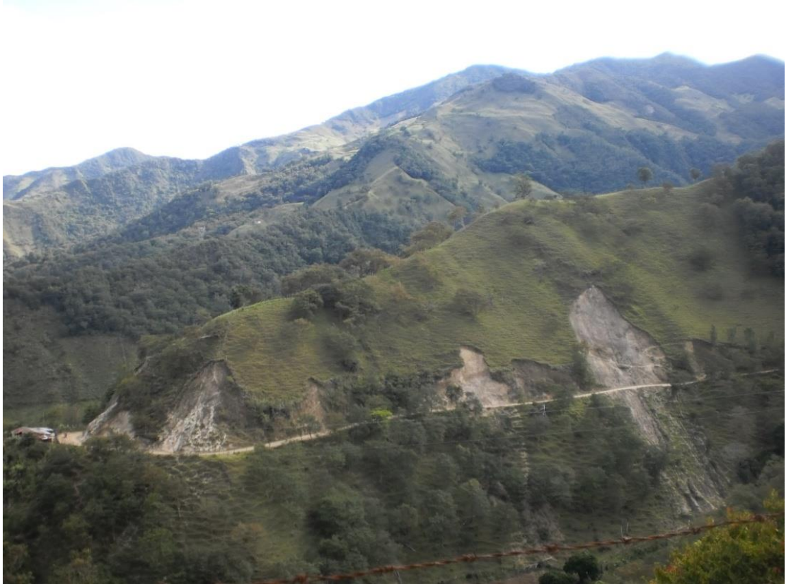
Figura 22. Movimiento en masa de estilo sucesivo, ubicado sobre la vía principal que comunica al municipio de villa Caro con el corregimiento de Carmen de Nazaret. Orientación de la foto: SW
