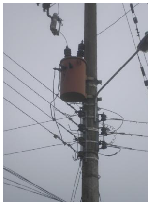
Figura 13. Transformador monofásico.
