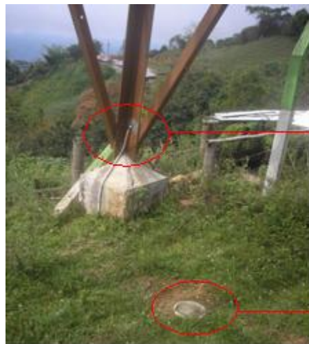
Figura 28. Bajante y electrodo de puesta a tierra de la torre de comunicación.
