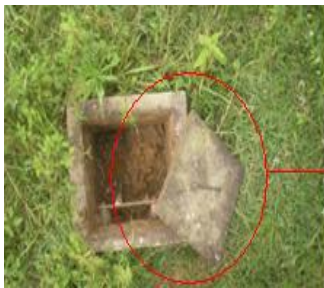
Figura 28. Bajante y electrodo de puesta a tierra de la torre de comunicación.
