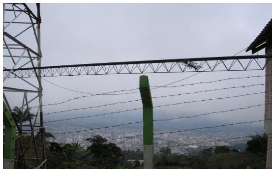
Figura 31. Bandeja portacables.
