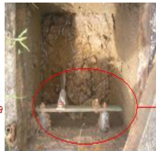
Figura 28. Bajante y electrodo de puesta a tierra de la torre de comunicación.
