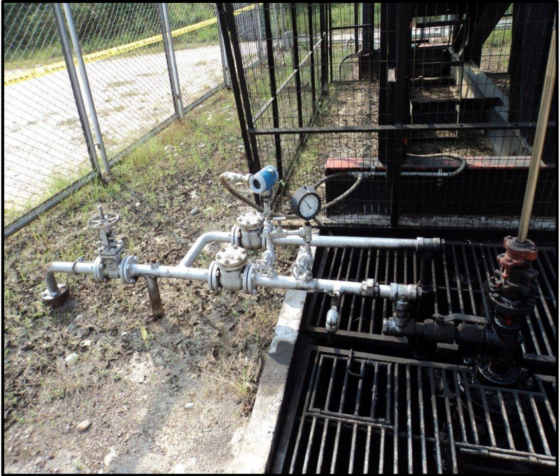
Figura 16. Pozo 6 sin la válvula BPR instalada.
