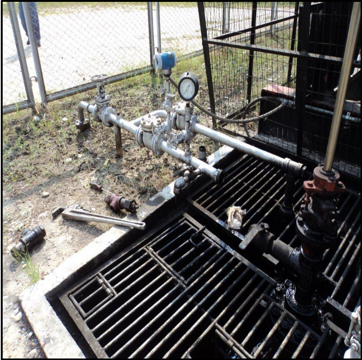
Figura 17. Pozo 6 durante la instalación de la válvula BPR.
