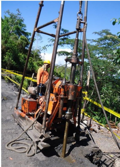
Figura 15. Equipo de perforación mecánica
