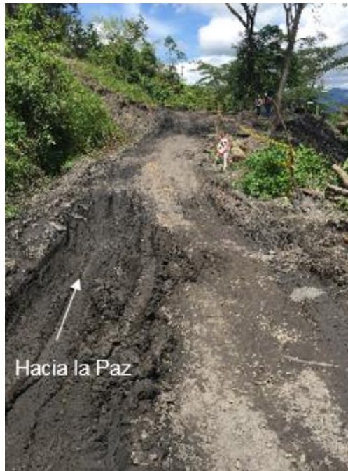
Figura 5. Estado actual del corredor vial
