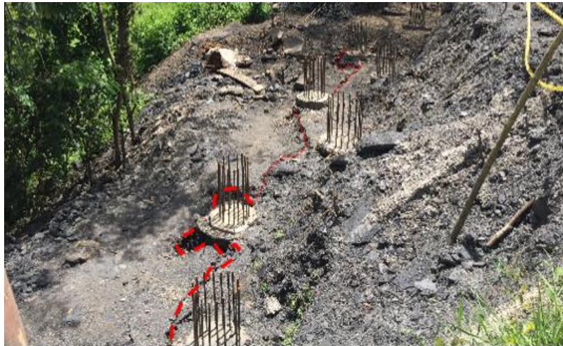
Figura 3. Des alineamiento de filas de caissons
