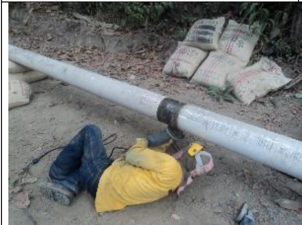
Limpieza entre pases de los cordones de soldadura
