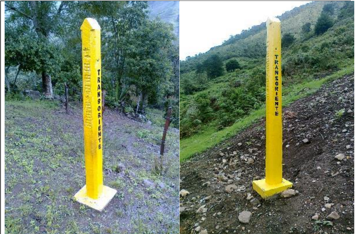
Postes de abscisado en concreto, indicando la empresa dueña de la línea y el kilómetro de ubicación
