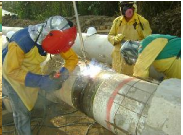
Soldadura de tubería de 18" para gasoducto Cupiagua-Cusiana
