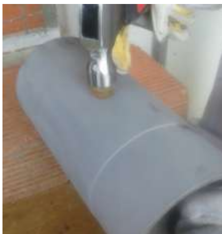
Figura 2. Inserción del tapón en la falla
