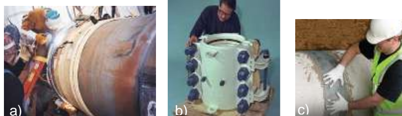
Figura 1. Tipos de reparaciones: (a) Soldada. (b) Metálica. (c) No metálicas
