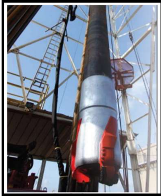
Figura 23. Perforación con casing.
