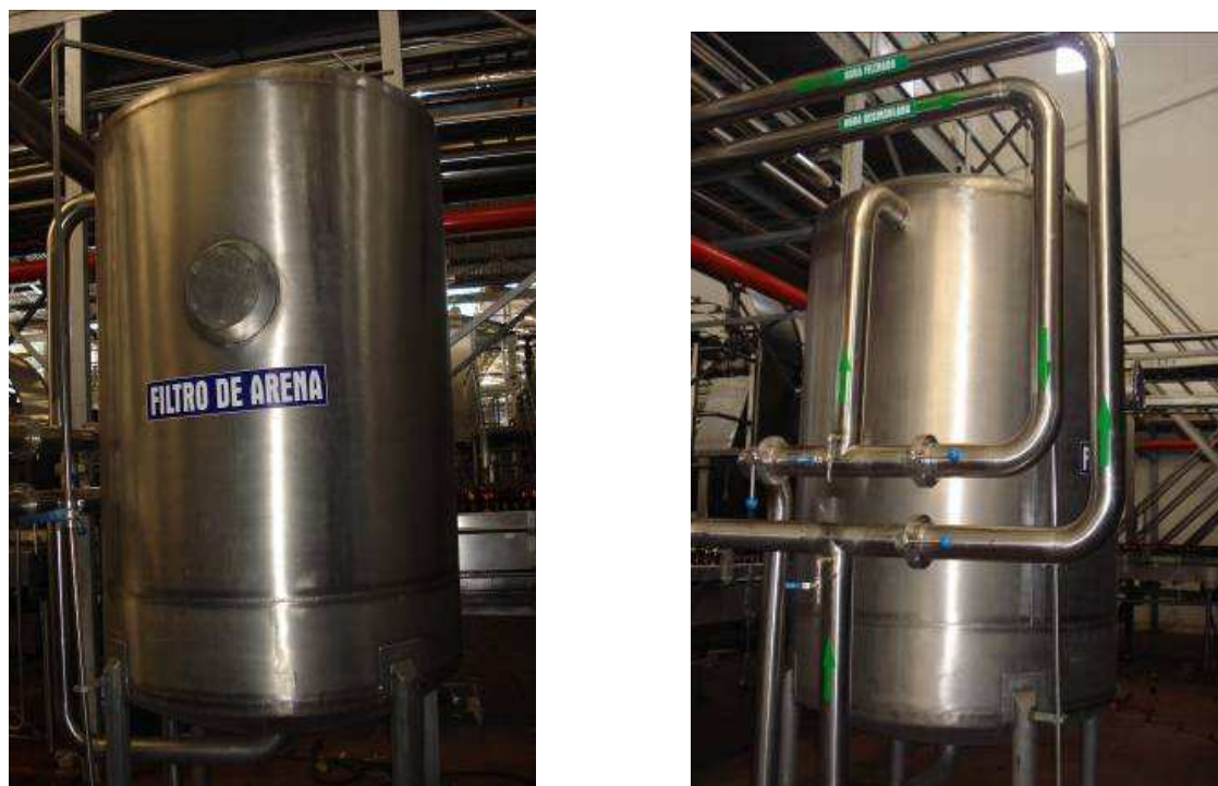
Figura 20. Filtro de arena de lecho profundo Tren 2
