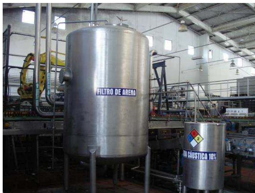
Figura 21. Filtro de arena de lecho profundo Tren 1.
