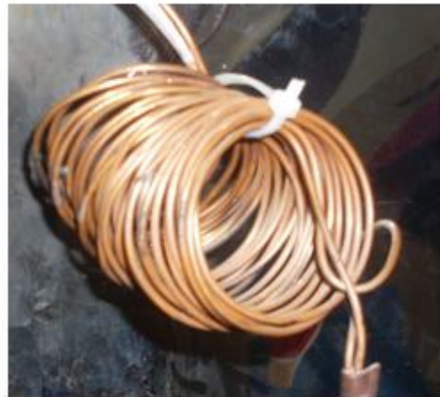
Figura 105. Tubo capilar
