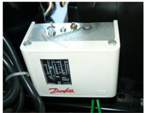
Figura 111. Presóstato Danfoss.
