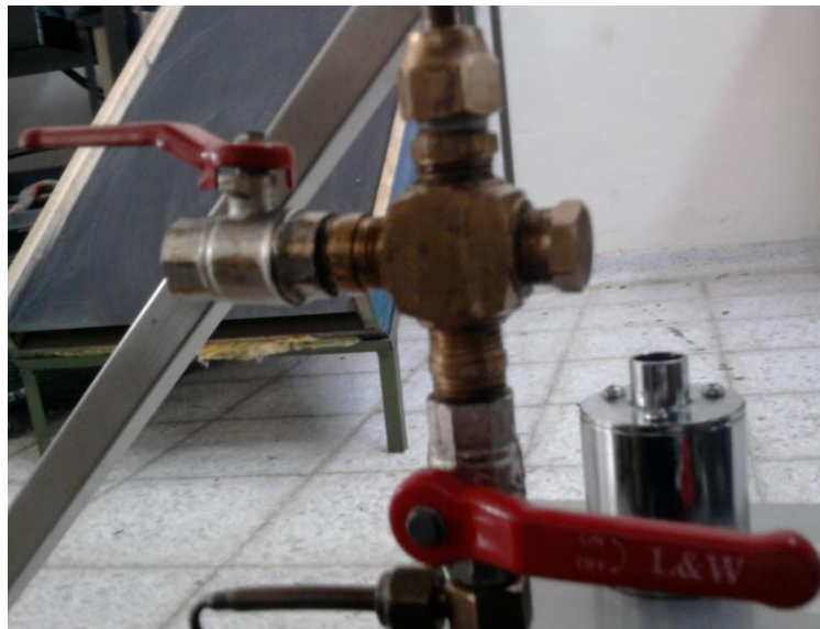
Figura 37. Llaves de paso a la bomba de vacío.
