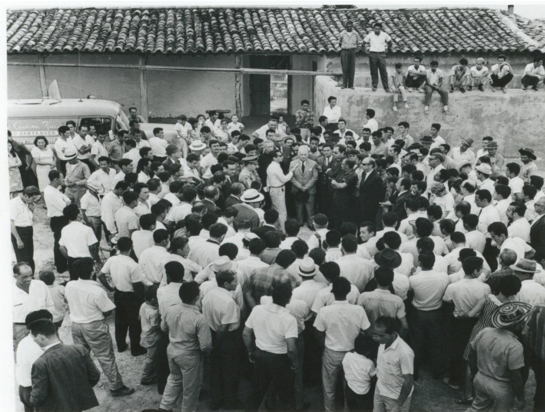
Figura 8. Inauguración de la explanación del Aeropuerto Palonegro 135
