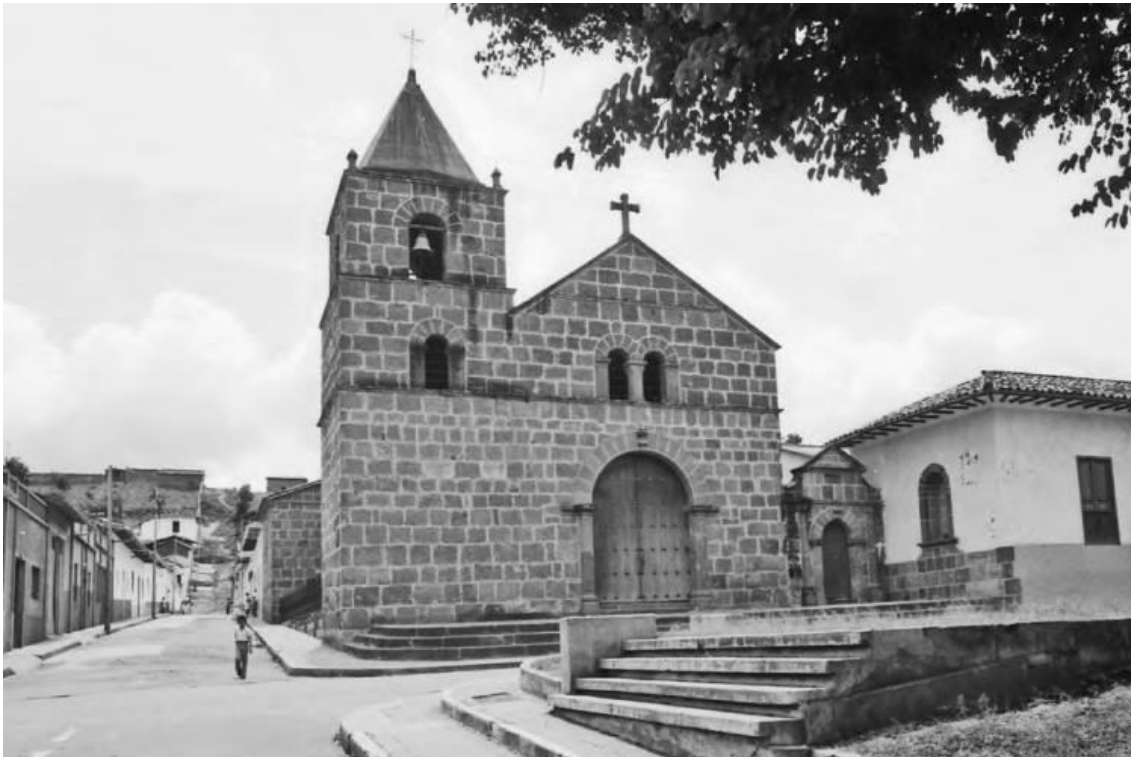
Figura 3. Capilla Santa Bárbara en Zapatoca 127
