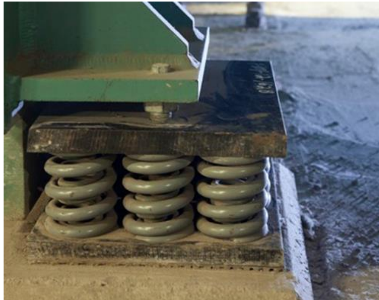
Figura 8. Aislante de vibración de resorte
