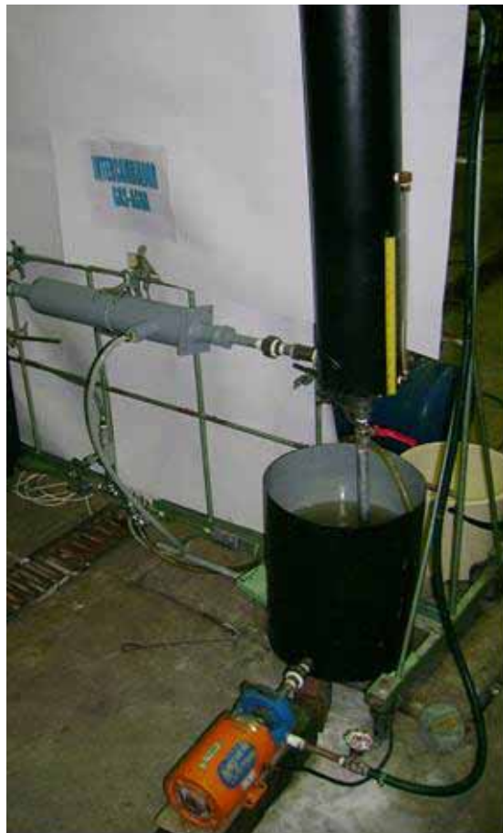
Figura 17. Zona de depuración del sistema
