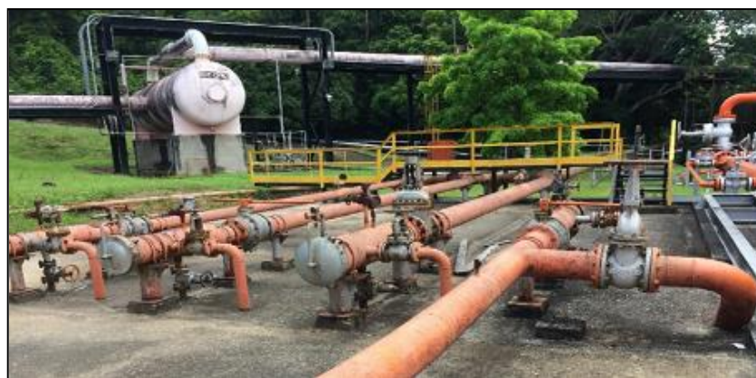
Figura 16. Punto de entrada de la corriente de gas La Cira.
