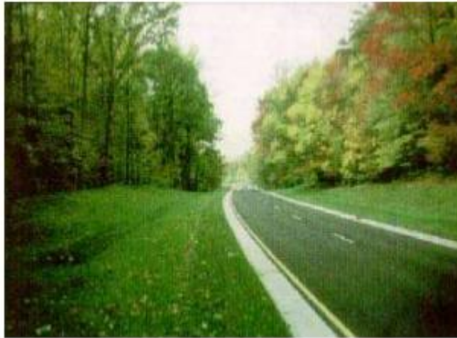
Figura 46. Condiciones ideales de una Zona Lateral.. Fuente: Manual para el Tratamiento de Zonas Laterales de Zonas Laterales en Carreteras Colombianas.
