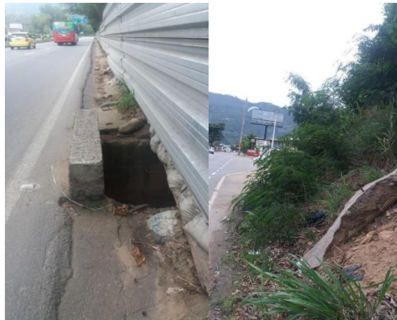
Figura 37. Alcantarillado y cuneta.
