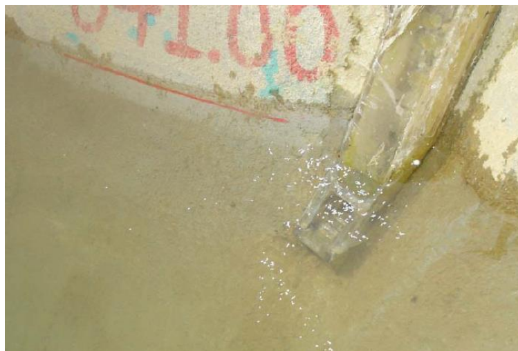
Foto 14. Partículas en suspensión que no son succionadas por la captación inferior operando como descarga de fondo.
