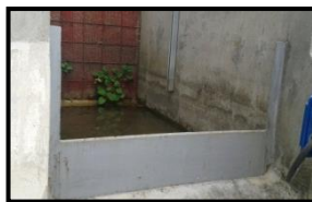
Foto 6. Vertedero de Pared Delgada, Localizado en la entrada del Embalse.
