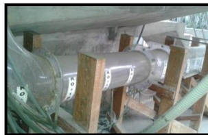
Foto 4. Canal de Excesos. P = 6.8%
