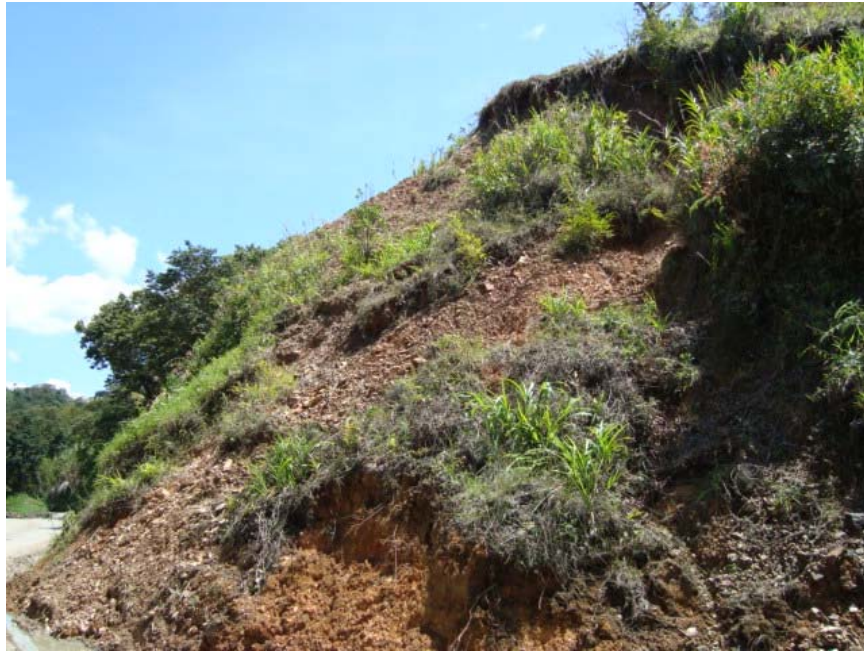
Figura 28. Deslizamiento, Severidad Media (Puente Nacional-Florián).
