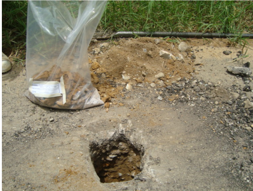
Figura 6. Apiques para determinación de espesores de las capas y características del pavimento.
