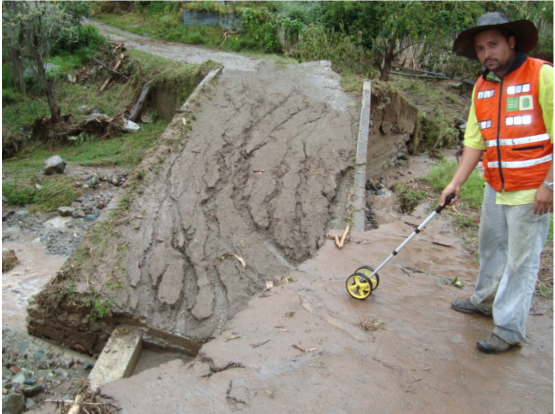
Figura 15. Inspección de puentes.
