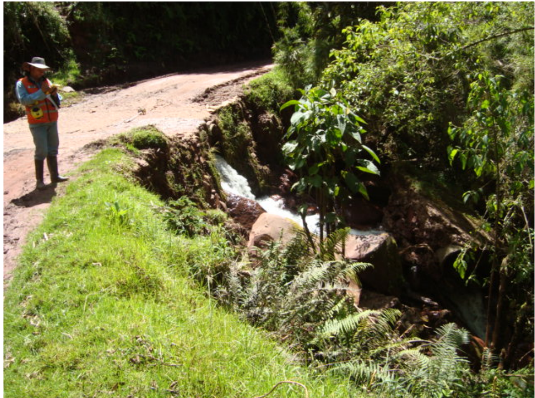
Figura 12. Inspección de obras de drenaje.
