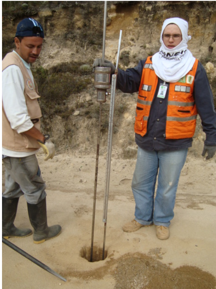
Figura 16. Apiques y ensayos de penetrómetro de cono dinámico.
