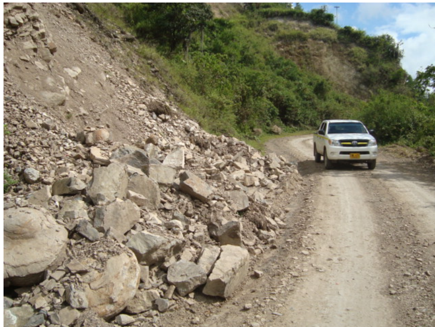
Figura 28. Deslizamiento, Severidad Media (Puente Nacional-Florián).
