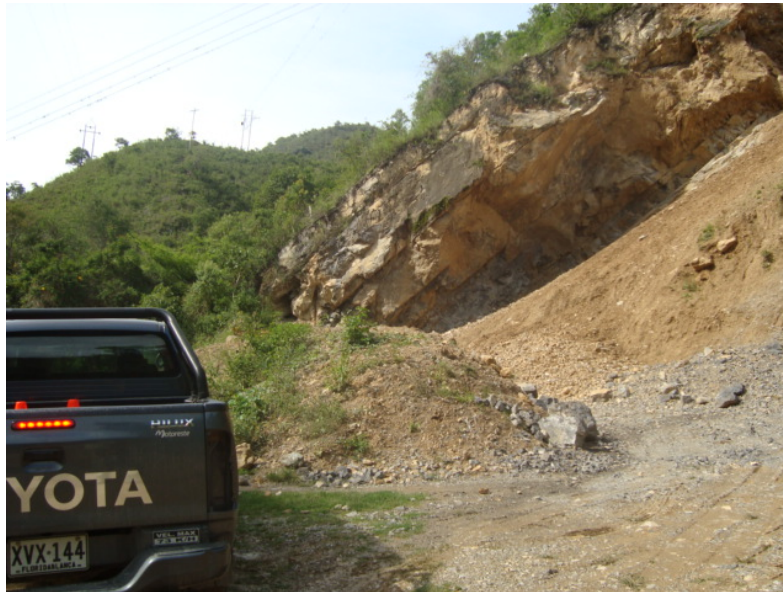
Figura 32. Derrumbe, Severidad Alta (Bucaramanga-Matanza-California).
