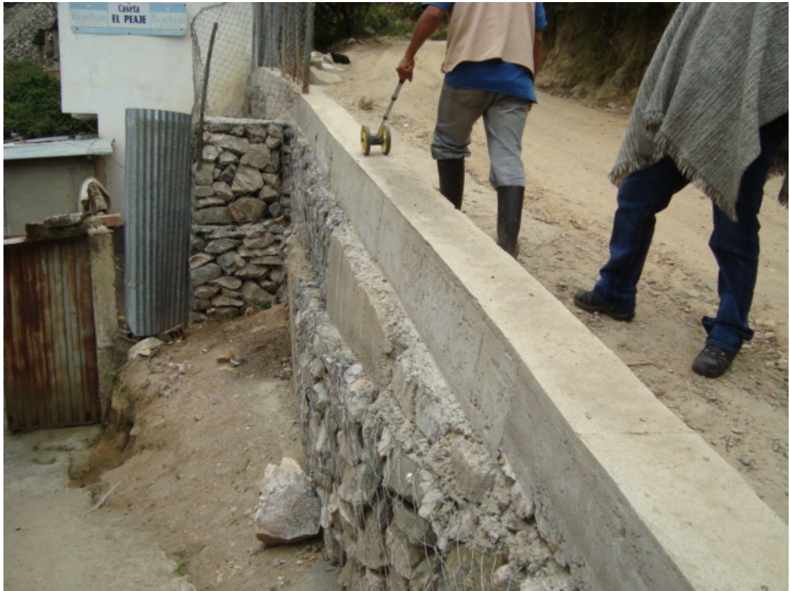
Figura 13. Inspección de muros de contención.
