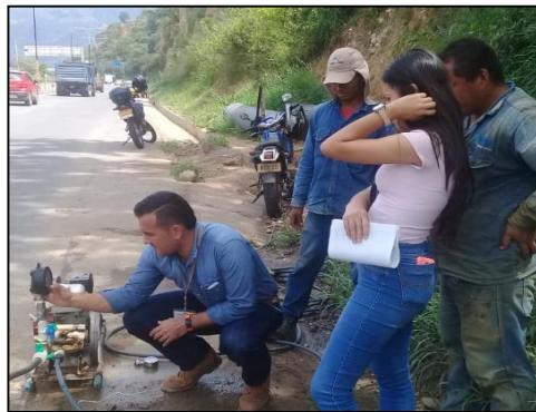
Figura 10. Registro fotográfico de una prueba hidráulica.
