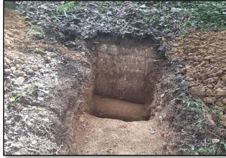
Figura 13. Apique realizado en el predio del vivero para ubicación de red antigua.
