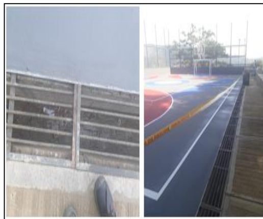
Figura 15. Registro fotográfico del canal de aguas lluvias en el Barrio Tejar Norte I.
