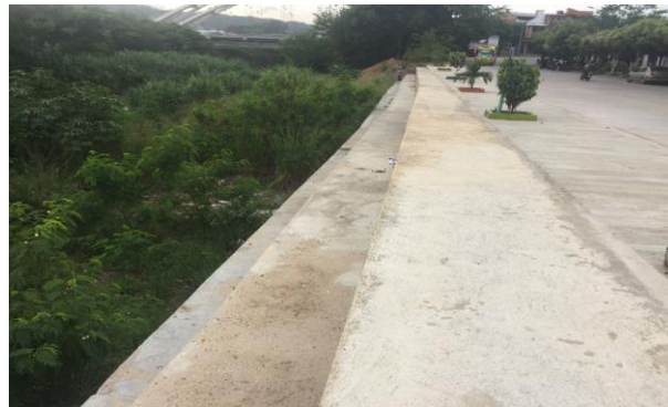
Figura 17. Vista general de muro existente.
