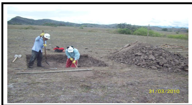
Figura 24: Adecuación del área de perforación
