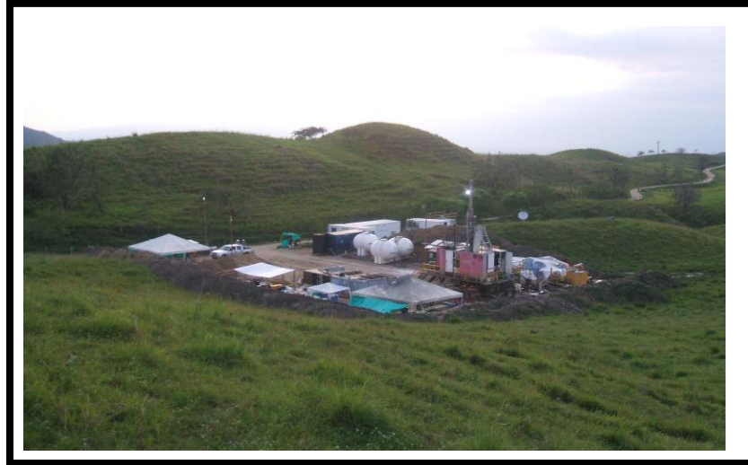
Figura 25: Campamento y adecuación del lay out.
