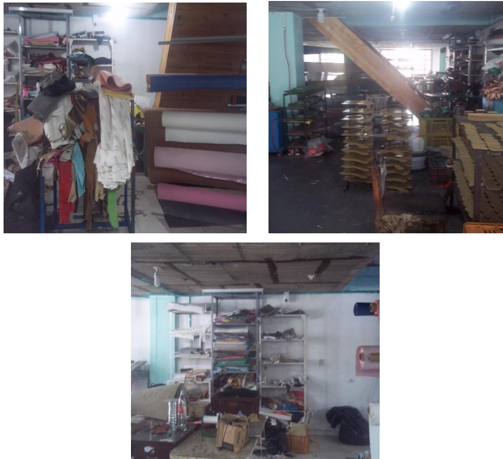
FIGURA 34. Retiro de escaleras y materiales área de corte laser
