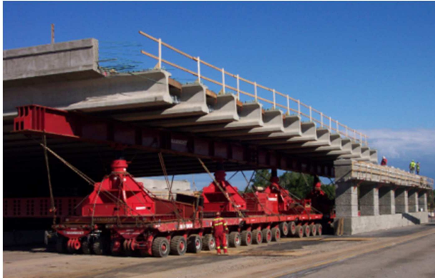
Figura 19 Subestructura del puente Maryland Ave sobre self-propelled modular transporter 20
