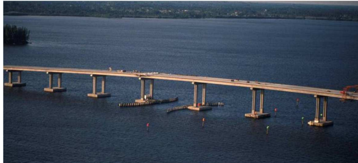
Figura 8 Subestructura puente Edison 8
