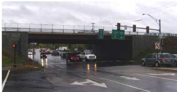
Figura 11 Sustitución finalizada de superestructura prefabricada 11
