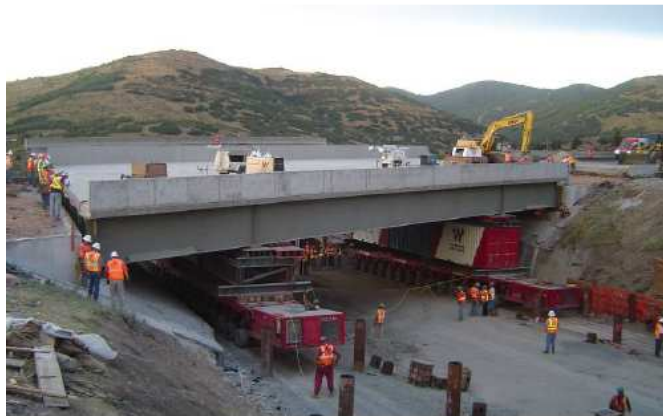
Figura 10 Sustitución de superestructura usando ESPP 10
