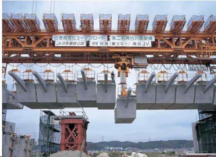
Figura 21 Montaje de segmentos de una viga del Viaducto Furukawa 22
