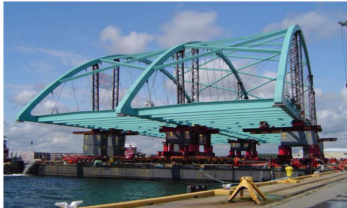
Figura 7 Superestructura prefabricada de acero 7
