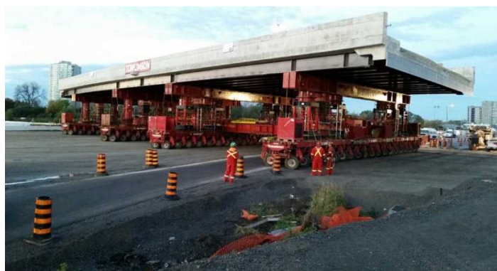
Figura 6 . Superestructura prefabricada de concreto 6
