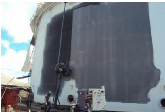
Figura 1. Limpieza y mantenimiento de superficies de tanques API.
