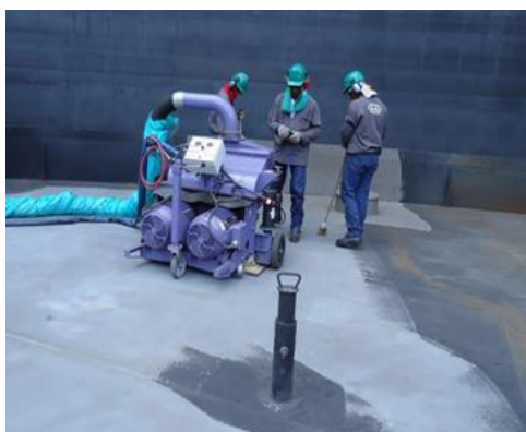
Figura 4. Limpieza de superficies con granalladora.
