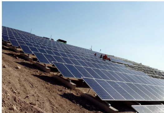
Figura 9. Sistema de paneles solares fotovoltaicos en el relleno sanitario La Loma los Colorados, Chile. Nota. Tomado de: Induambiente Recuperado de: https://www.induambiente.com/especial/energia/hagase-la-luz
