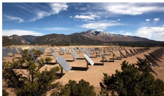
Figura 23. Sistema de paneles solares fotovoltaicos en la mina de Chevron Questa. Nota. Tomado de: https://durangoherald.com/articles/22585
