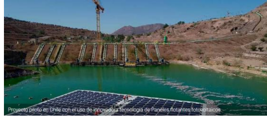
Figura 25. Paneles solares fotovoltaicos flotantes sobre el embalse artificial en la mina de cobre Los Bronces, Chile. Nota. Tomado de: https://www.worldenergytrade.com/index.php/m-news-alternative-energy/96-news-energia-solar/4432-la-mina-los-bronces-de-chile-instala-innovadores-paneles-solares-flotantes
