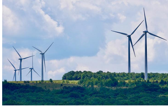
Figura 29. Sistema de energía eólica en mina abandonada de Somerset, Estados Unidos Nota.
