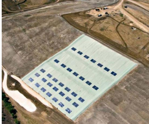
Figura 5. Sistema de paneles solares fotovoltaicos sobre el relleno sanitario Tessman Road. Nota. Tomado de: “Tessman road landfill solar energy cover”
