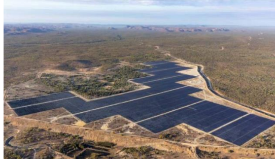
Figura 33. Sistema de paneles solares en una mina de oro clausurada en Queensland, Australia.
