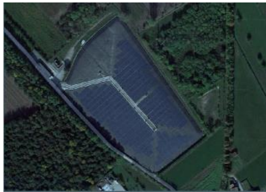
Figura 11. Instalación de paneles solares fotovoltaicos en relleno sanitario de Tiretta, Italia. Tomado de: “Solar Landfills: Economic, Environmental, and Social Benefits”
