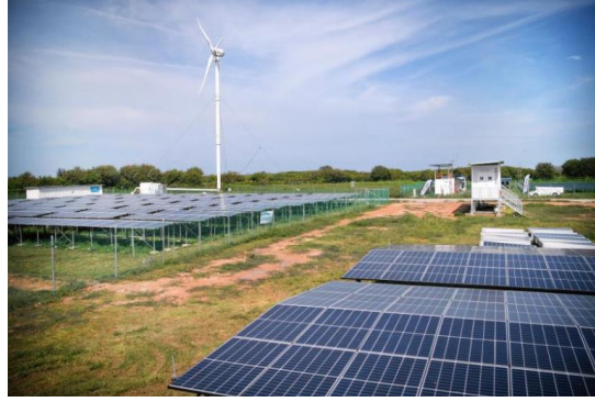
Figura 21. Sistema híbrido de energía eólica en el relleno sanitario de Semakau, Singapur. Nota. Tomado de: https://www.straitstimes.com/singapore/energy-comes-clean-at-singapores-only-landfill-semakau
