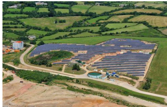
Figura 26. 5600 paneles solares situados en la antigua mina de Wheal Jane, Reino Unido. Nota. Tomado de: https://premierconstructionnews.com/2011/08/26/from-mining-tin-to-harvesting-the-sun/
