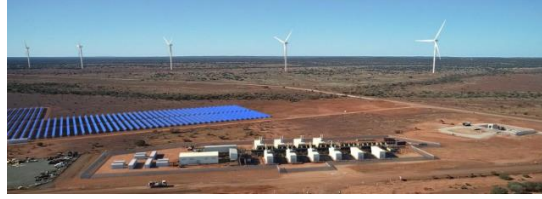
Figura 35. Sistema de paneles solares fotovoltaicos y turbinas eólicas en la mina de Agnew, Australia. Nota. Tomado de: https://www.miningmagazine.com/power-remote-power/news/1365714/gold-fields-invests-in-hybrid-power-for-agnew
