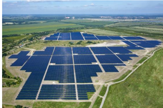
Figura 22. Sistema de paneles solares fotovoltaicos situados en la antigua mina de Meuro, Alemania. Nota. Tomado de: https://en.wikipedia.org/wiki/Solarpark_Meuro
