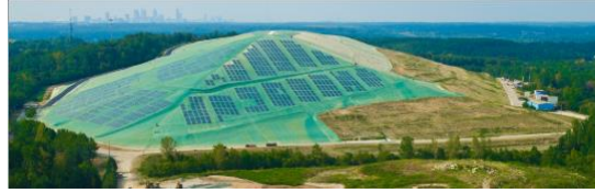
Figura 8. Paneles solares fotovoltaicos flexibles situados sobre el relleno sanitario de Hickory Ridge, Estados Unidos. Tomado de: Hdrinc Recuperado de: https://www.hdrinc.com/portfolio/hickory-ridge-landfill
