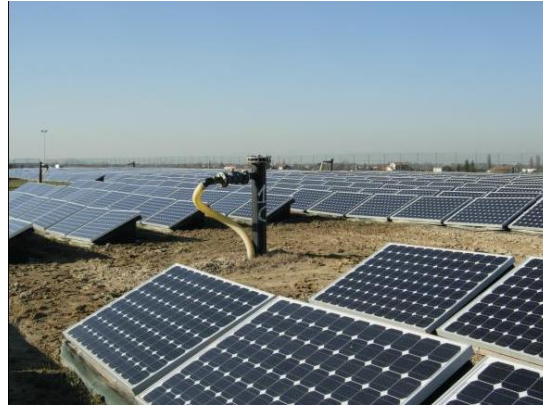
Figura 20. Sistema híbrido de extracción de biogás y paneles solares fotovoltaicos en el relleno sanitario de Roncayette, Italia. Nota. Tomado de: http://novambiente.altervista.org/Impianto-fotovoltaico-sulla-ex-discardica.html
