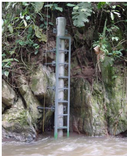
Figura 16. Detalle del anclaje a la roca
