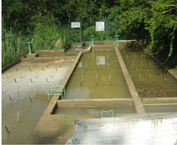
Figura 5. Vista compuerta y muro de la bocatoma.
