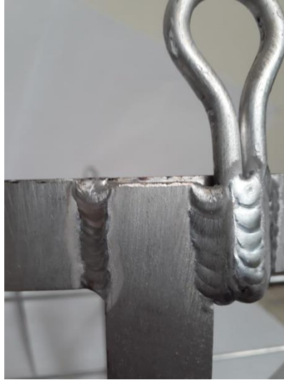
Figura 31 Ejemplo cordón de soldadura
