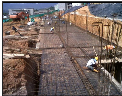
Figura 12. Acero de refuerzo
