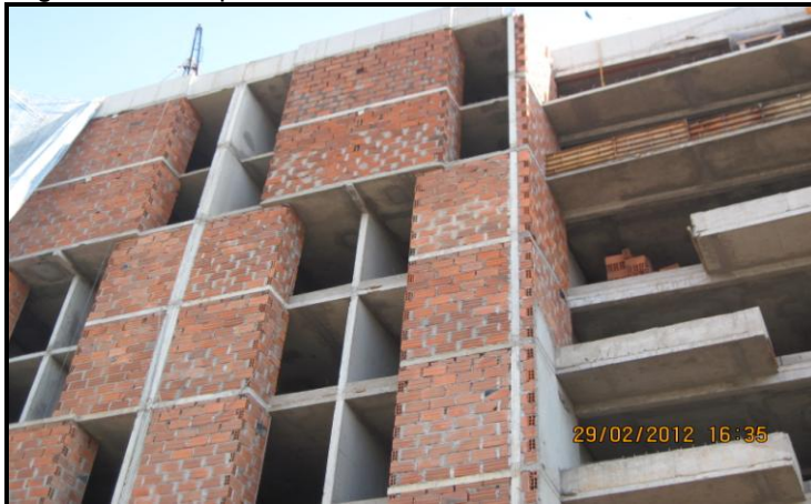
Figura 13. Mampostería no estructural
