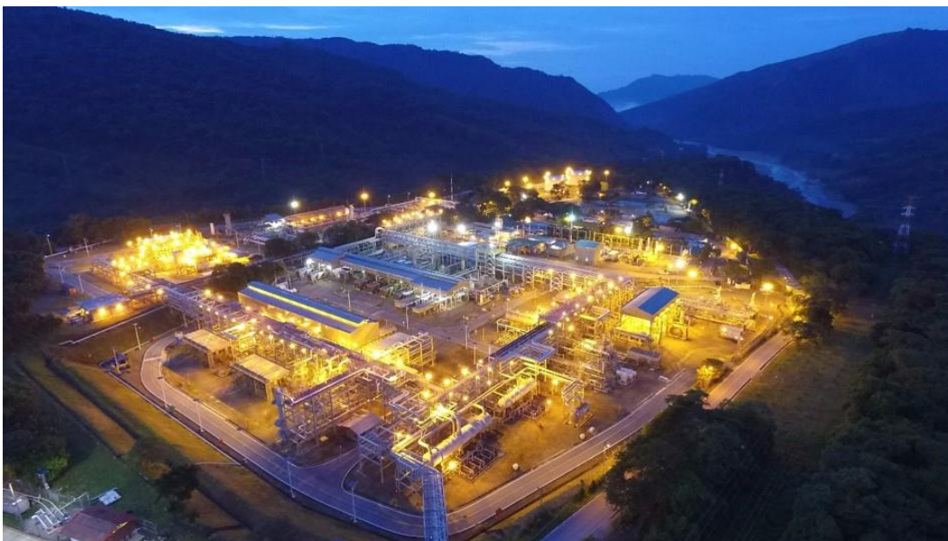
Figura 1. Vista aérea CPF Floreña
