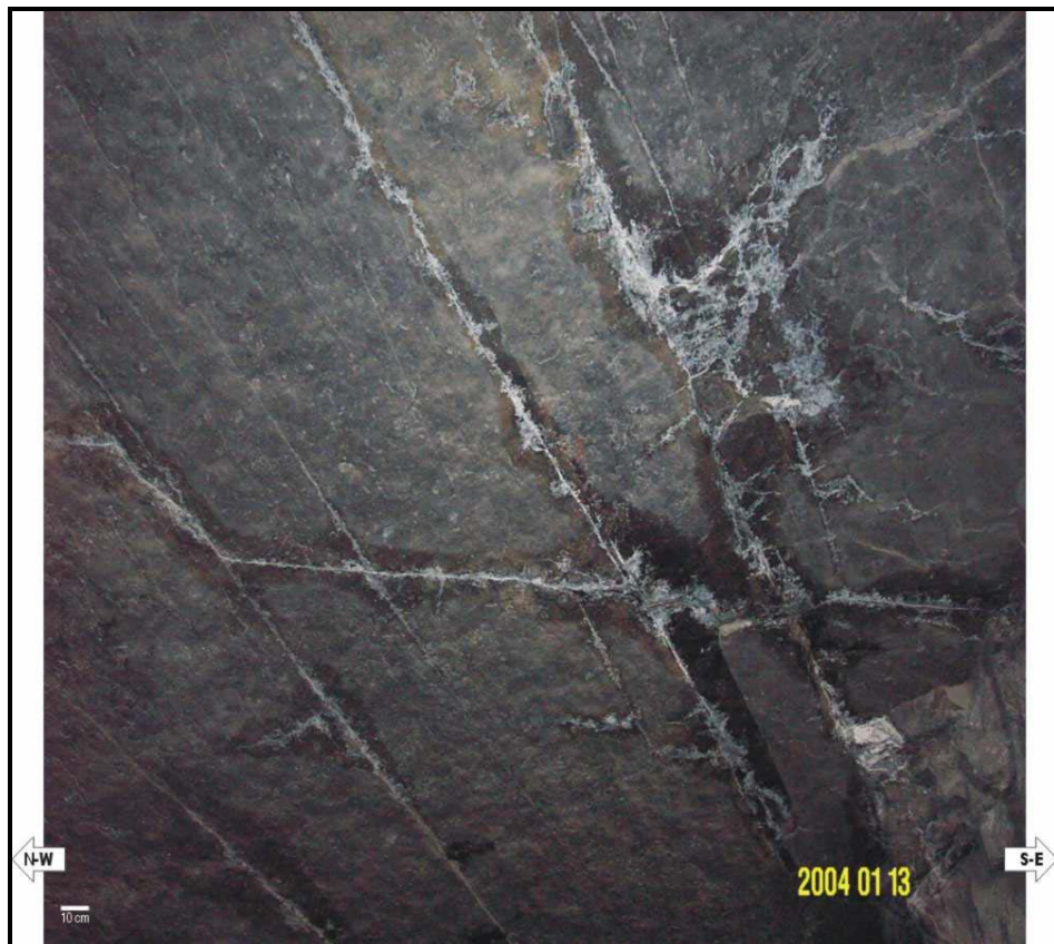
Figura 18. Fracturas afectadas por procesos de infiltración
