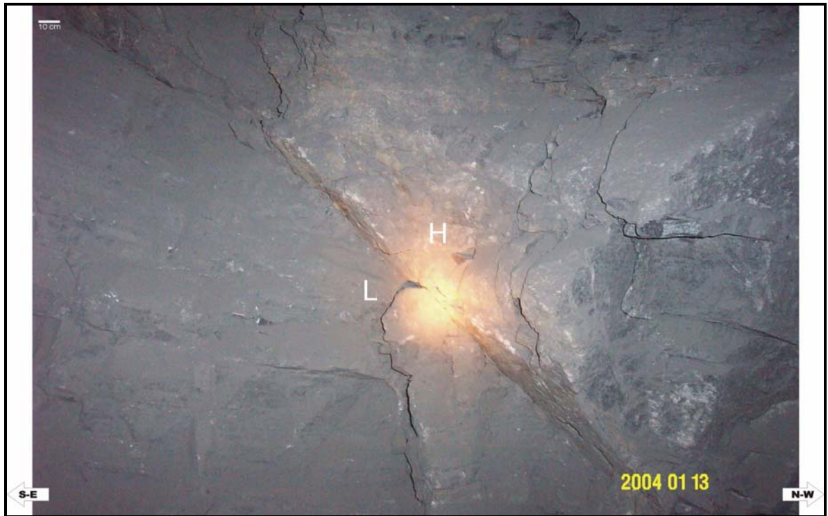
Figura 15. Imagen de la falla observada en el Túnel 6 de la Mina “El Carrancho” Costado derecho del túnel.
