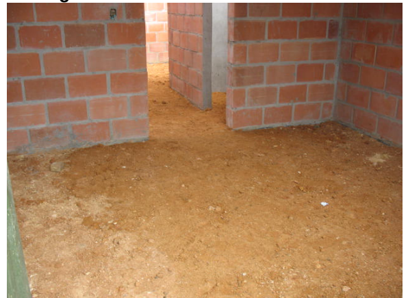
Figura 62 Piso en tierra terminado.
