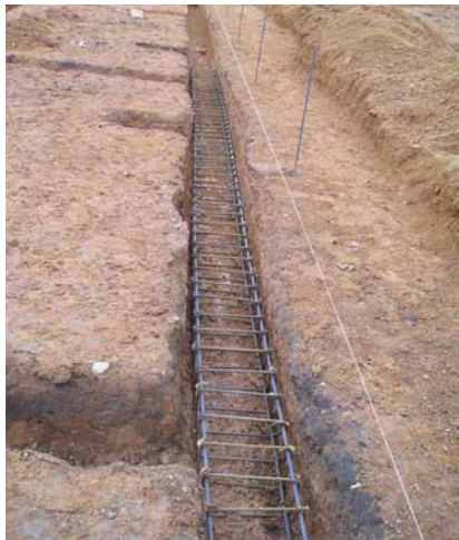
Figura 38. Canasta Centrada en la zanja
