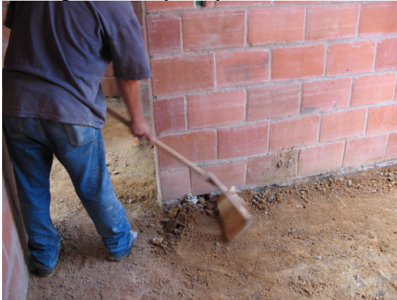
Figura 61 Limpieza piso en tierra.
