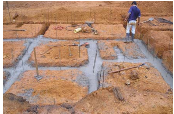
Figura 43. Cimientos De una vivienda fundidos
