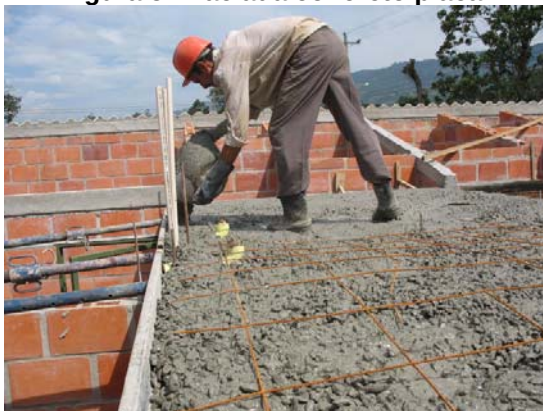
Figura 57 Vaciada concreto placa.
