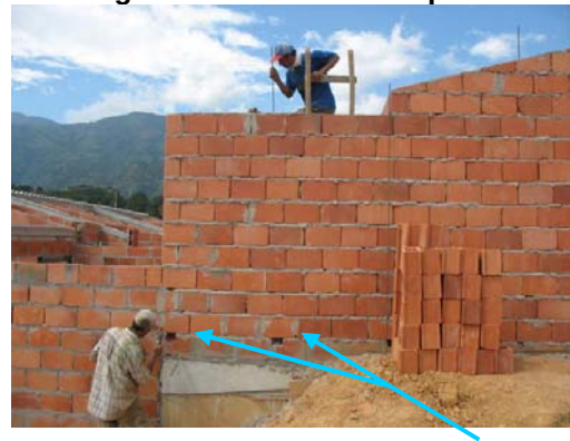
Figura 51. Celdas de inspección
