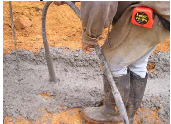
Figura 41. Vibrado concreto
