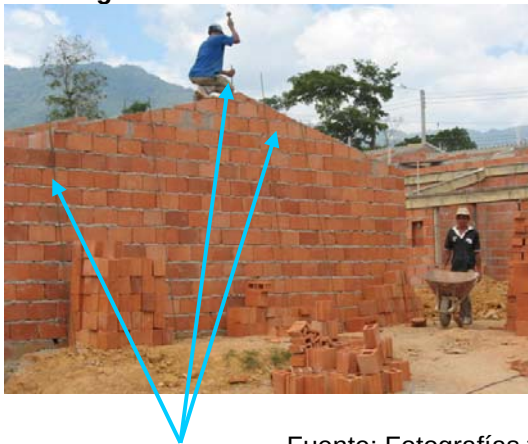
Figura 50. Colocación de hierro.
