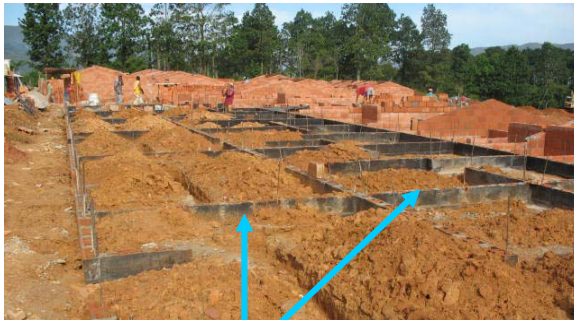
Figura 44. Terraza con sobre cimientos.
