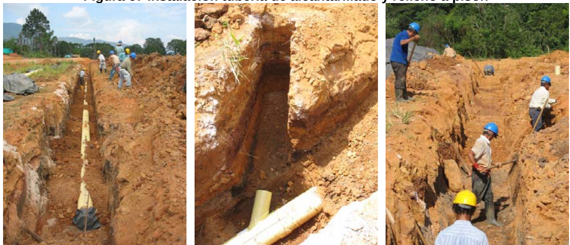
Figura 67 Instalación tubería de alcantarillado y relleno a pisón
