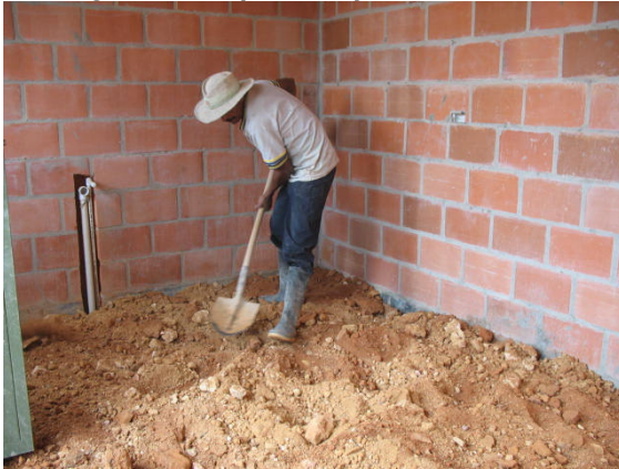
Figura 59 Replanteo piso en tierra.
