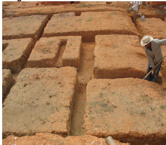
Figura 35. Excavación de una vivienda.
