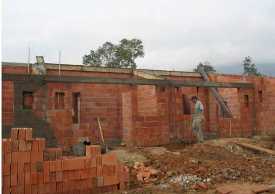
Figura 52. Formaleta de viga parte frontal.
