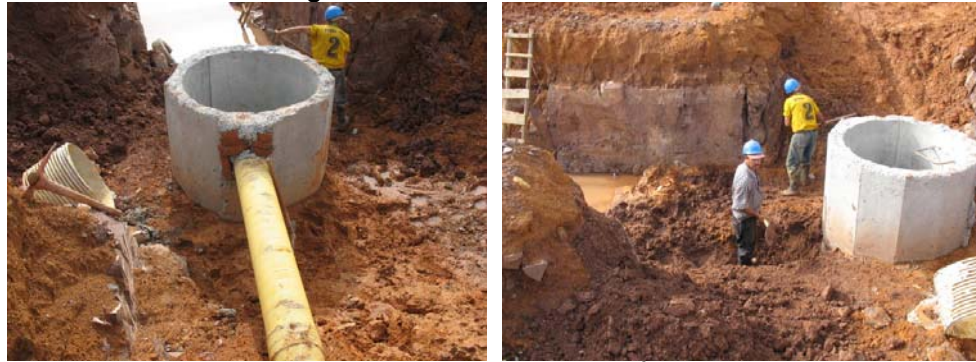
Figura 68 Pozos de alcantarillado
