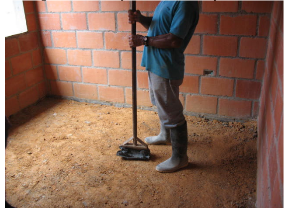
Figura 60 Compactación con pisón.
