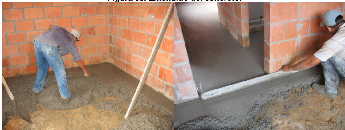
Figura 63. Extendido del concreto.
