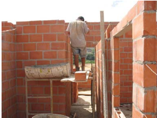
Figura 48. Colocación de realces.
