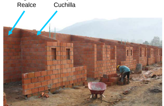
Figura 49. Mampostería terminada
