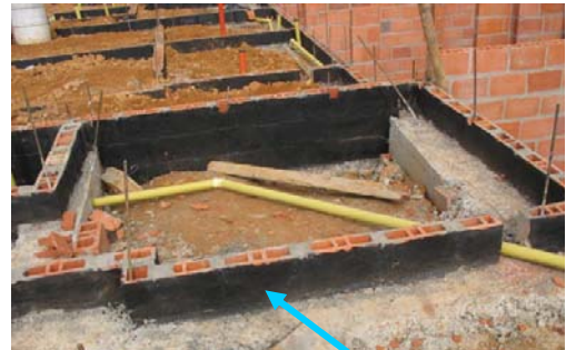
Figura 45. Impermeabilización.
