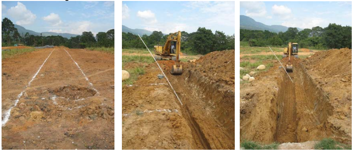
Figura 66 Excavación del alcantarillado con retroexcavadora
