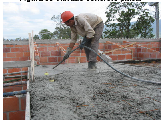
Figura 58 Vibrado concreto placa.
