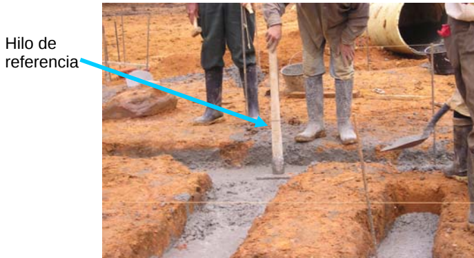
Figura 42. Verificación niveles de cimientos
