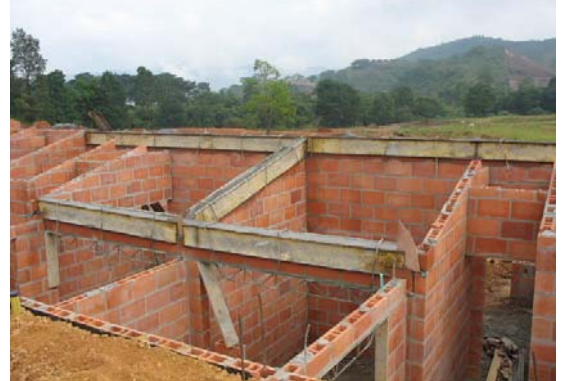
Figura 53. Formaleta de viga parte posterior
