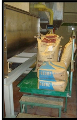
Figura 13. Ubicación del material en la mezcladora
