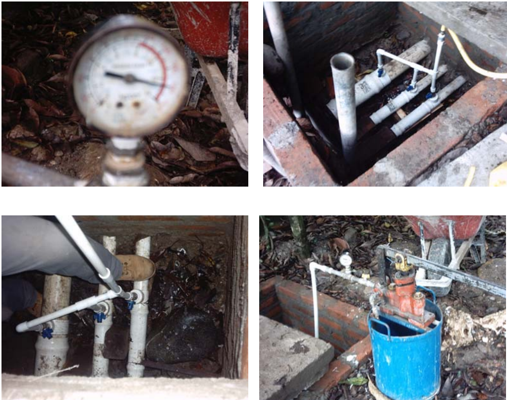
Figura 28.Prueba de presión a la tubería
