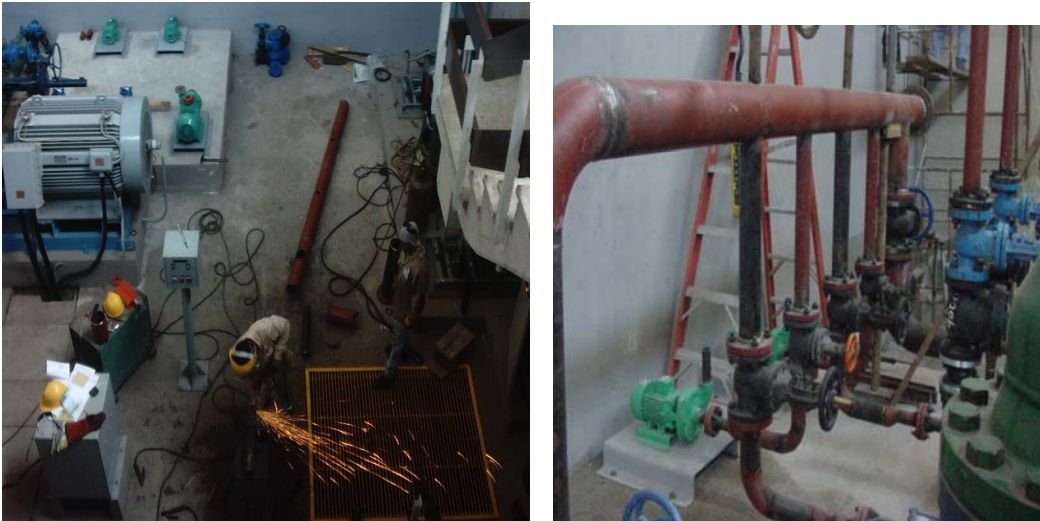
Figura 26. Proceso de instalación de la tubería de descarga de las bombas
