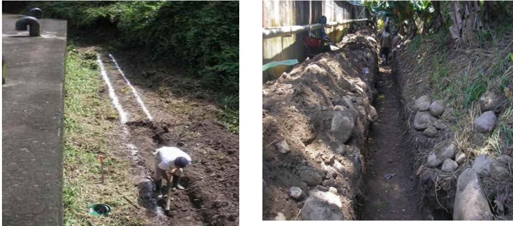
Figura 19. Excavación para la tubería
