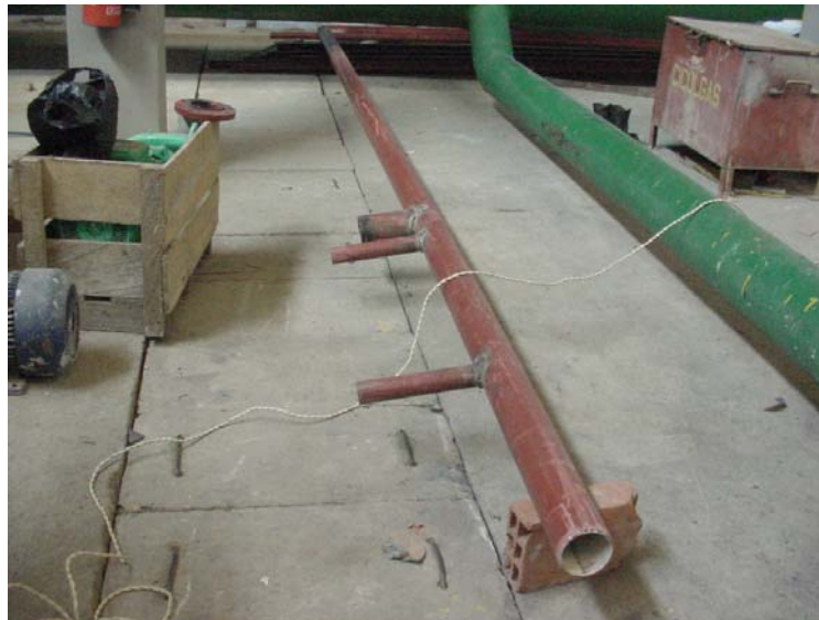
Figura 21. Tubería en acero realizado el sand-blasting y pintura primer
