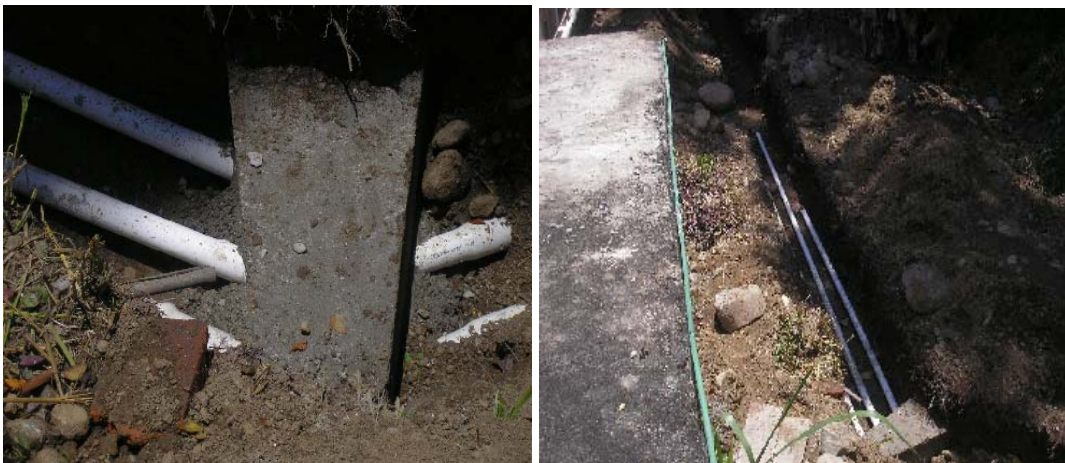
Figura 22. Instalación de tubería de PVC y atraques
