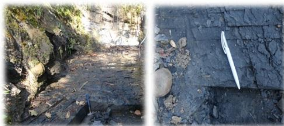
Figura 19. Diaclasas con buzamientos entre 80°-90° (verticales). Ubicada en la Quebrada el Palenque
