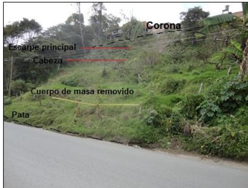
Figura 24. Deslizamiento Rotacional, vía Vélez-Barbosa.
