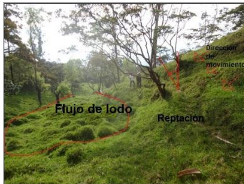
Figura 25. Evidencia de flujo de lodo y reptación, curvamiento de árboles.
