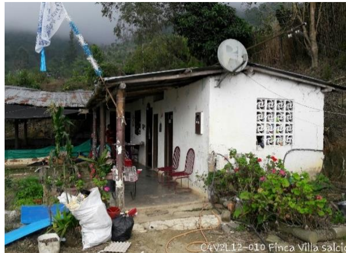
Figura 15. Sector Alsacia-Malavar C4V2I12-010 vista general.
