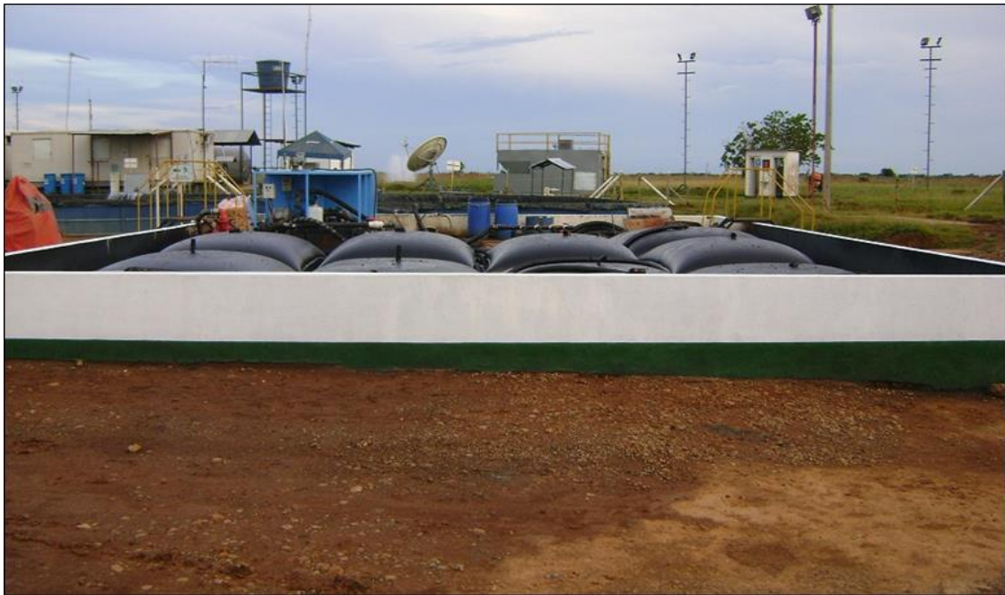
Figura 7. Tratamiento de deshidratación de flocs en geocontenedores año 2010 Campo Cabiona
