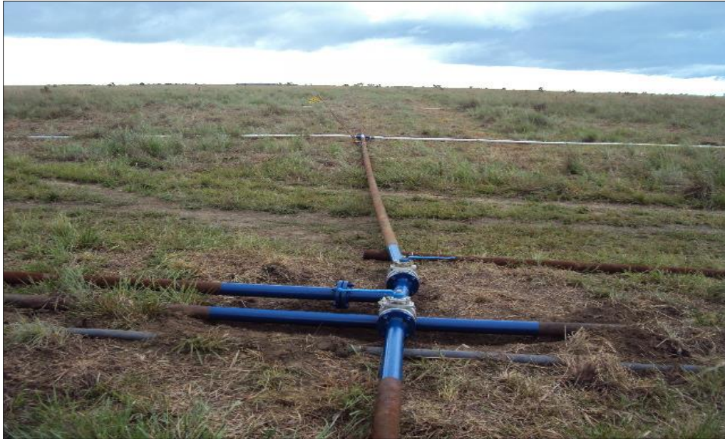
Figura 13. Área zona de aspersión 2.3 hectáreas, sectorizada en 4 secciones, Campo Cabiona
