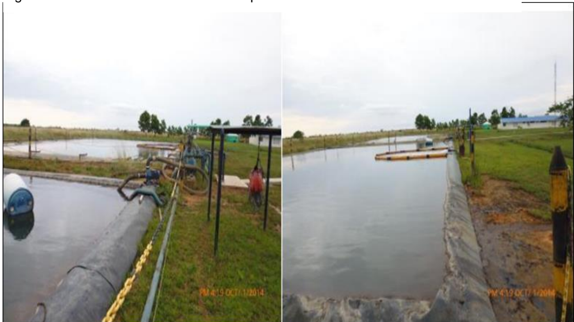
Figura 10. Piscinas de enfriamiento Campo Cabiona
