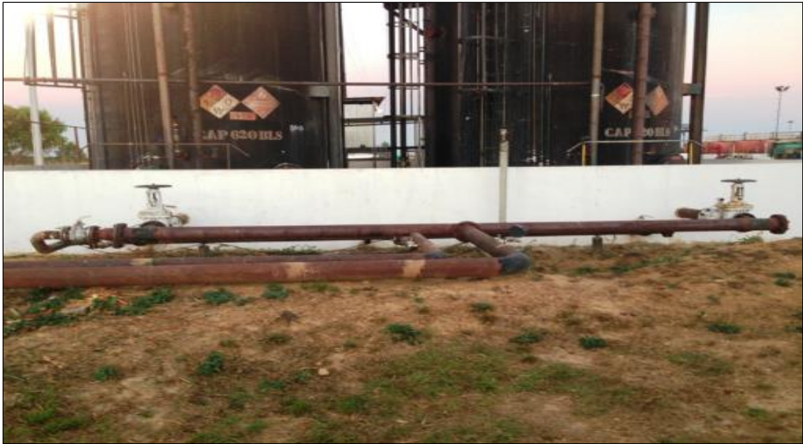
Figura 3. Gun Barrel 3 y 4, se realiza un primer lavado del crudo, luego pasa a los Gunbarrel 1 y 2 (opción de dirigir el fluido en serie o paralelo).
