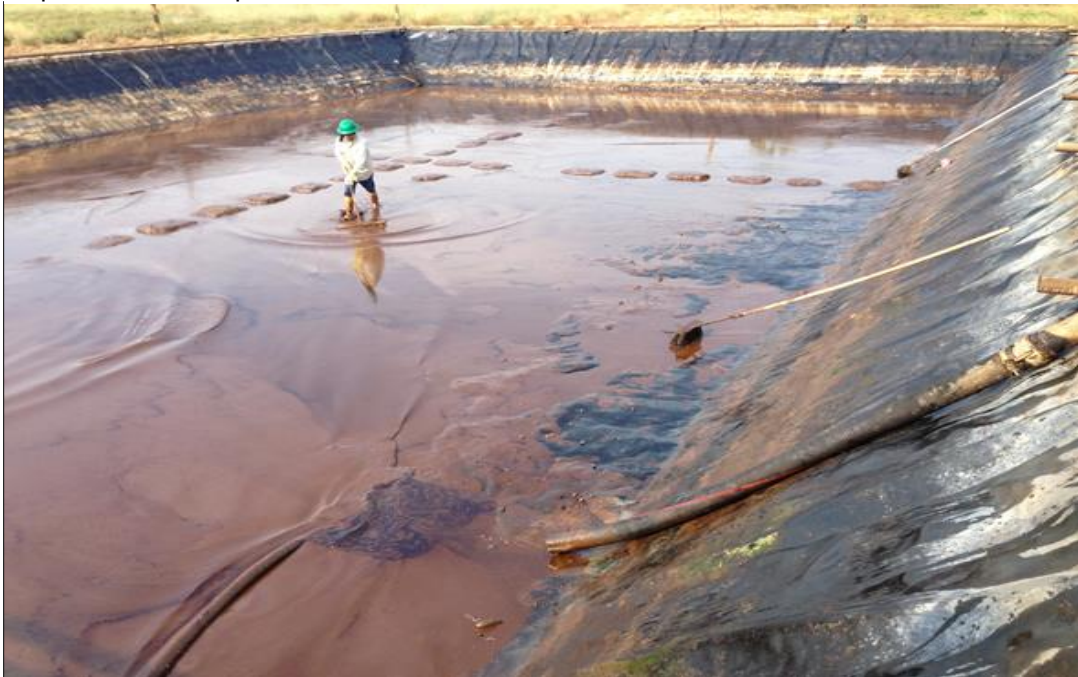
Figura 12. Contaminación de lodos y aceite a causa del deficiente tratamiento de las aguas de producción Campo Cabiona
