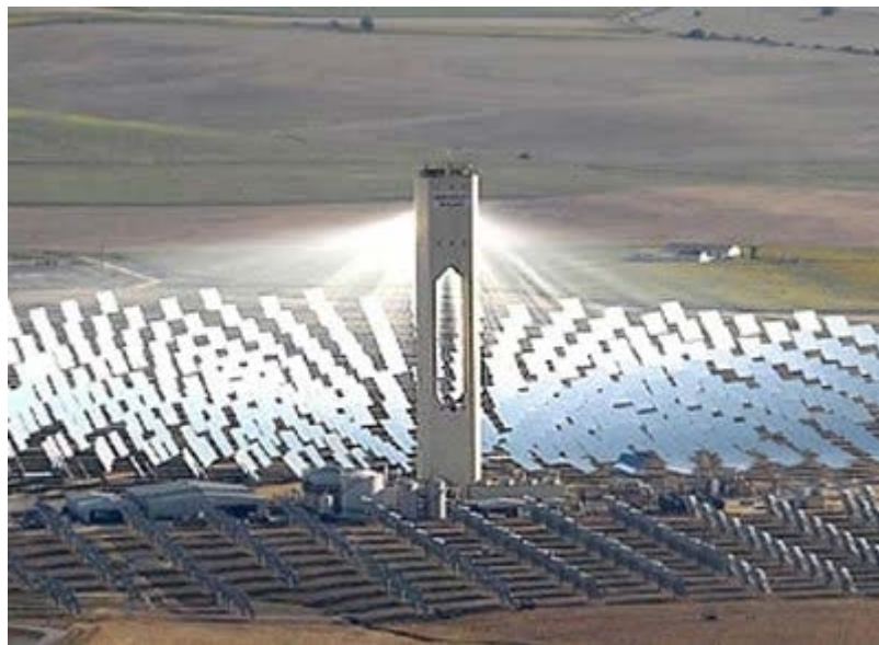
Figura 5. Planta generadora de energía con múltiples reflectores.
