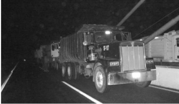
*Figura 5:* Camiones cargados ubicados en el puente durante las pruebas de carga
