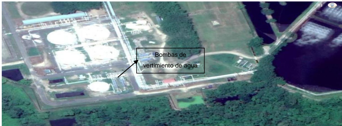
Figura 2 ubicación geográfica bombas de vertimiento PF-1
