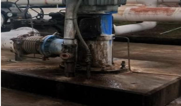
figura 26 bomba con sello prensaestopas
