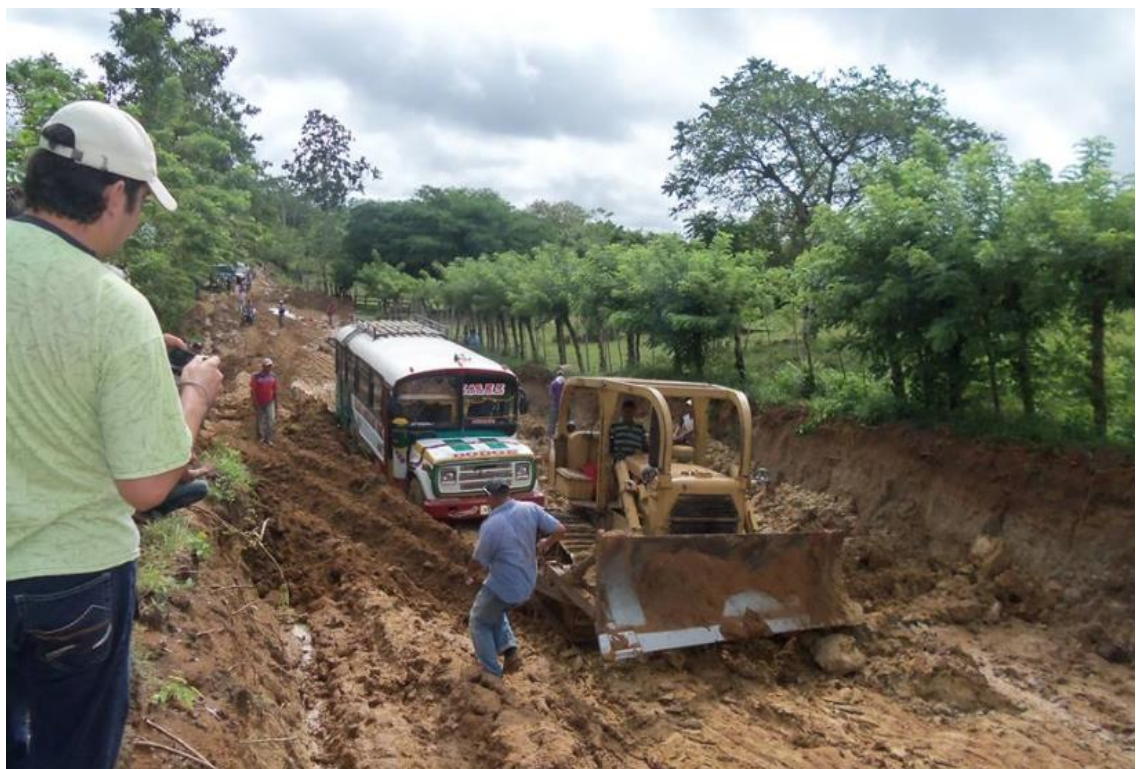
Figura 12. Estado de la vía en época invernal
