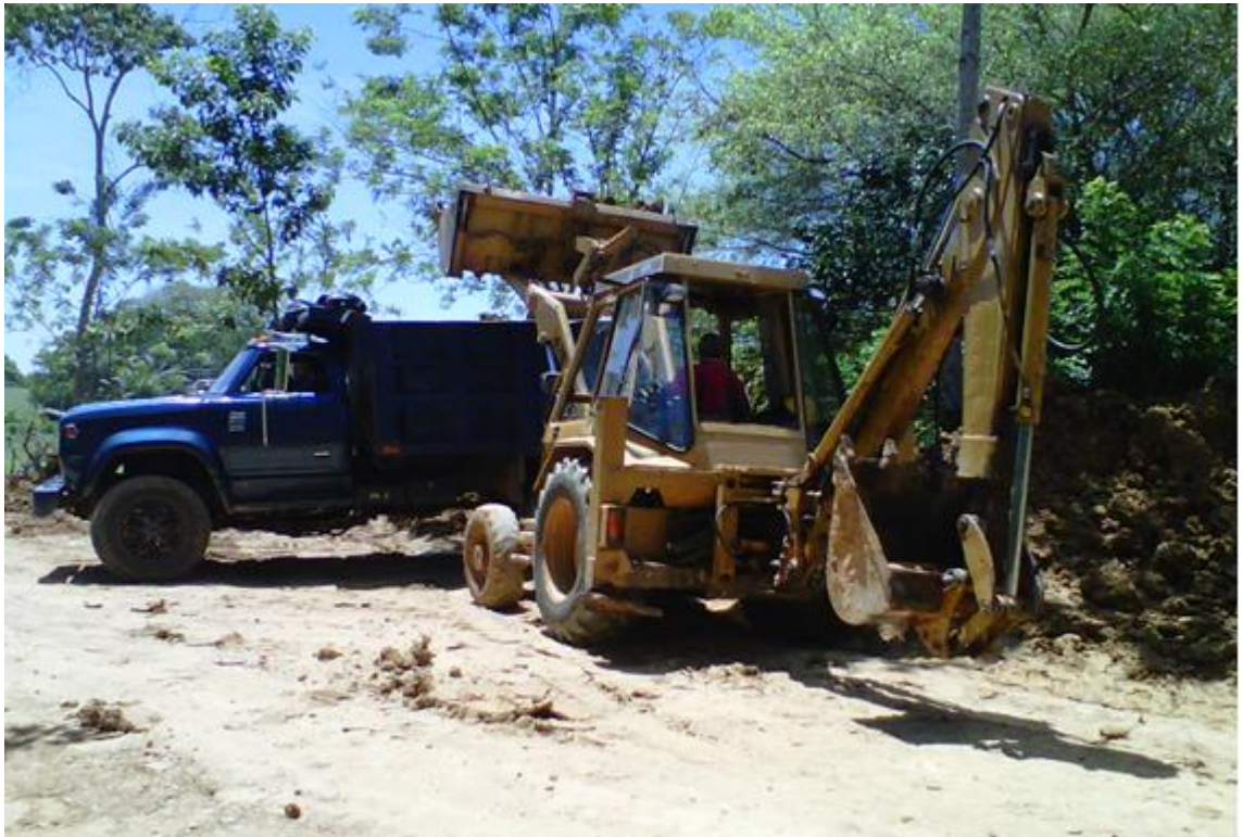
Figura 8. Proceso de excavación
