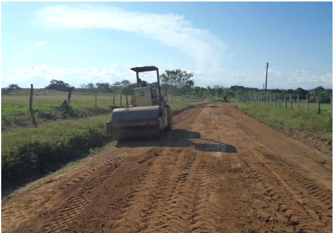
Figura 11. Proceso de compactación
