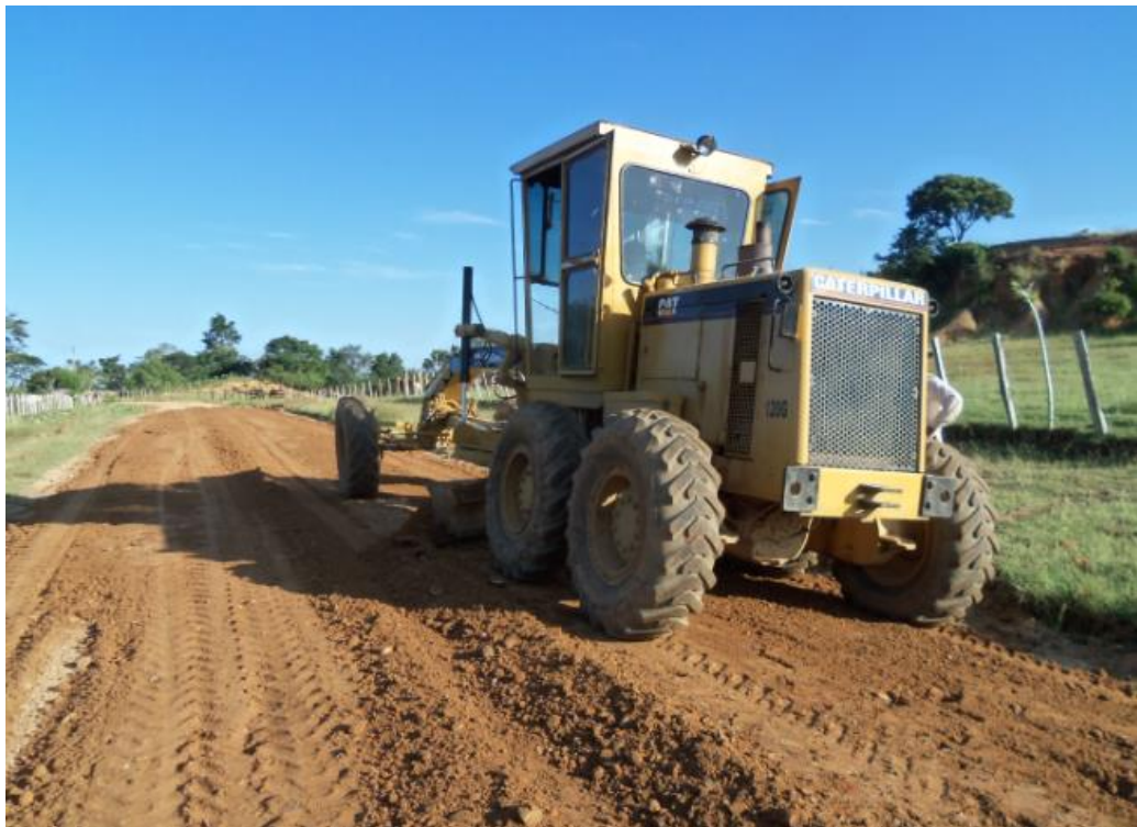
Figura 9. Proceso de Extendido
