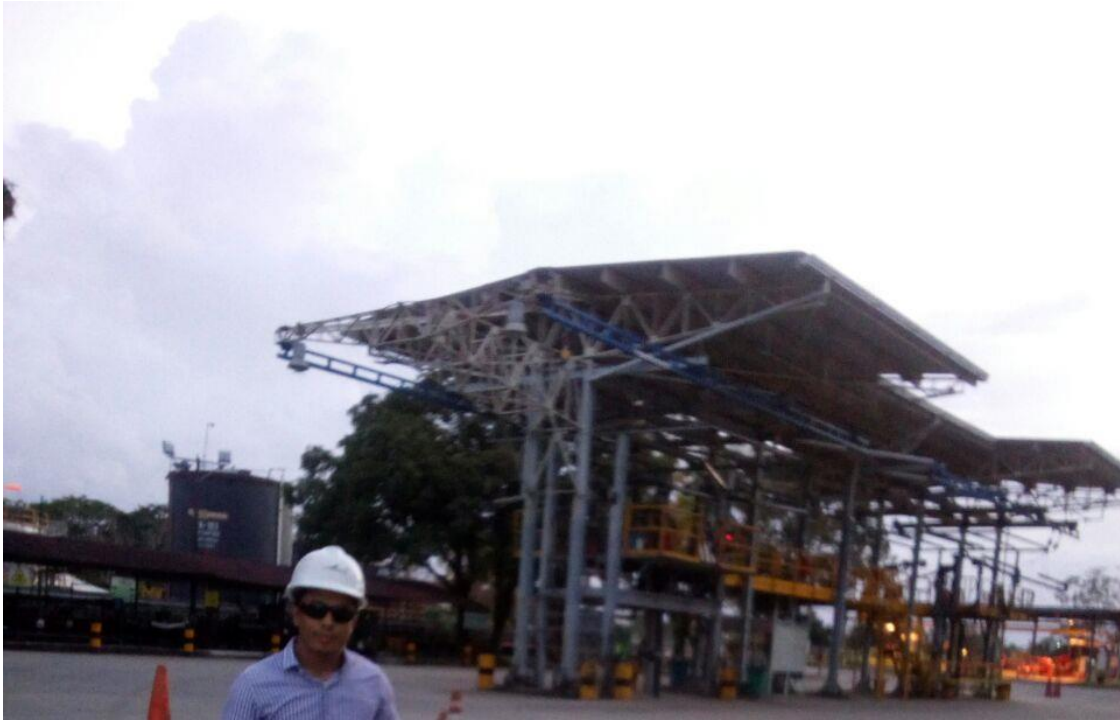
Fuente: PIÑERES. M (2017). Bombeo a despacho por carro tanque estación Acacias (figura). Recuperado de Estación Acacias municipio de Acacias, Meta
