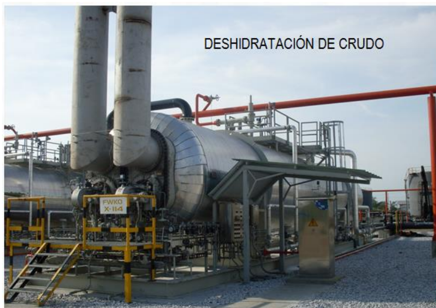
Imagen 11. Deshidratador de crudo.
