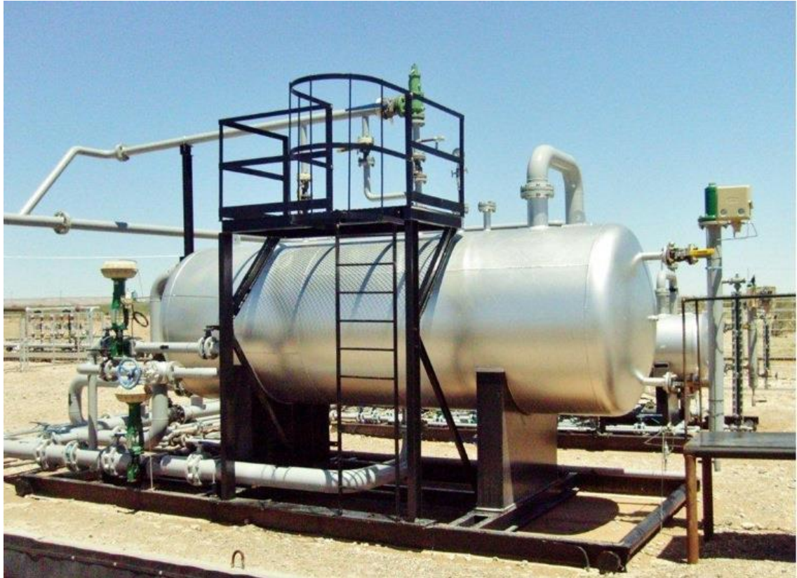
Imagen 8. Separador Trifásico.
