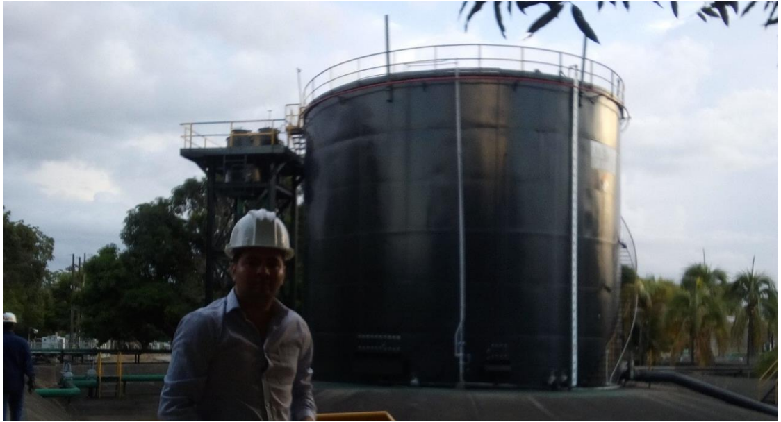
Imagen 14. Tanque de surgencia.
