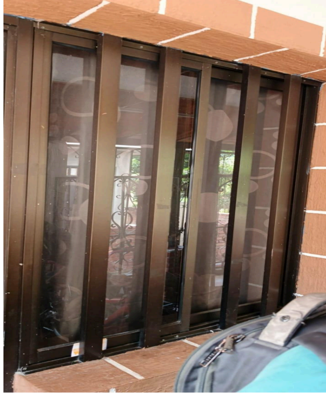
Figura 43. Portón de ingreso.
