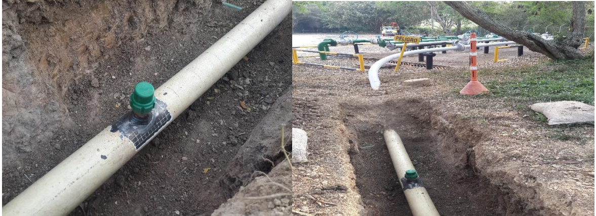
Figura 6. Montaje del portacupones
