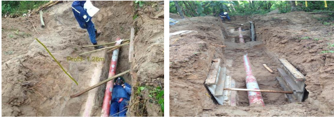
Figura 10. Excavación Tubería
