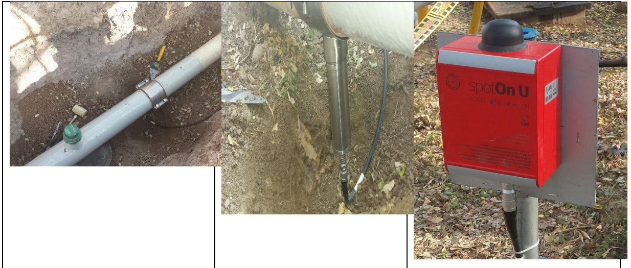
Figura 7. Instalación de SHM.
