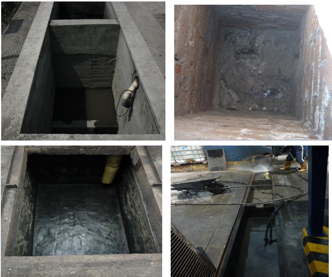
Figura 27. Mantenimiento planta de tratamiento de aguas residuales
