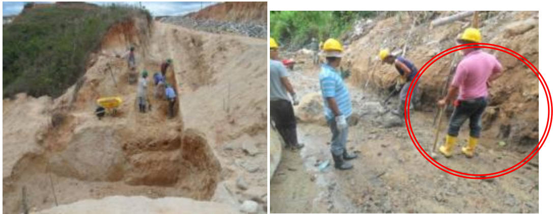
Foto 1. Movimiento de tierras Tramo Curos - Málaga
