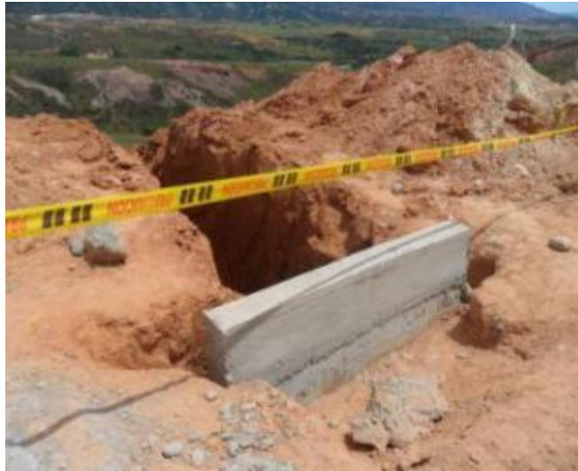
Foto 10. Desmonte de alcantarilla
