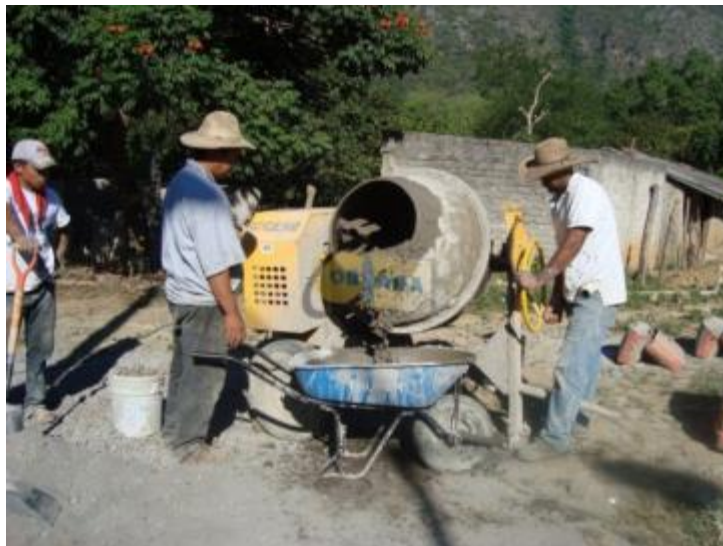
Foto 4. Preparación concreto
