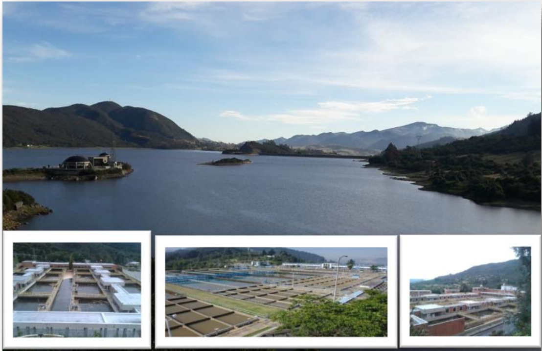
Figura 17. Planta de tratamiento Francisco Wiesner
