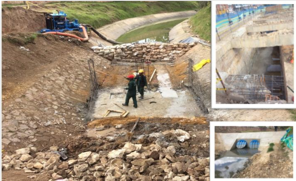
Figura 12. Ampliación, revestimiento y mantenimiento canales.
