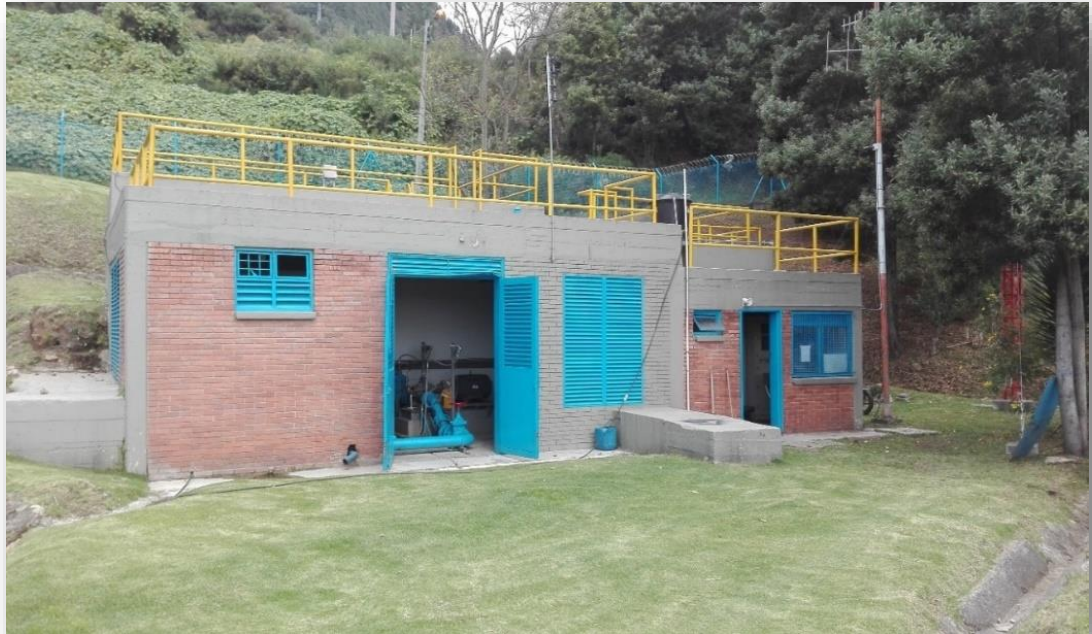
Figura 26: Estación de bombeo Paraíso I.
